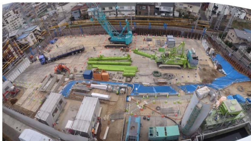
写真 3-4-4 施工状況 (平成 31 年 3 月時点当社HP公開)
