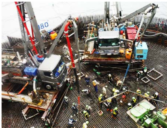
写真 3-4-3(1) 施工状況 (平成 30 年 12 月時点当社 HP 公開)
