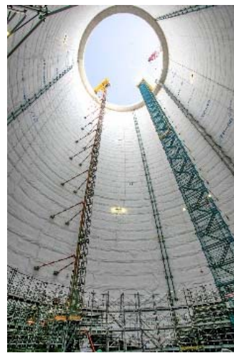
写真 3-4-3(2) 施工状況 (平成 30 年 12 月時点当社 HP 公開)
