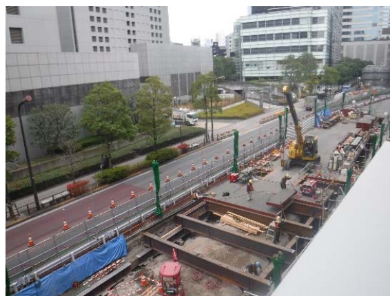
写真 3-4-1 施工状況 (平成 30 年 12 月時点当社HP公開)
