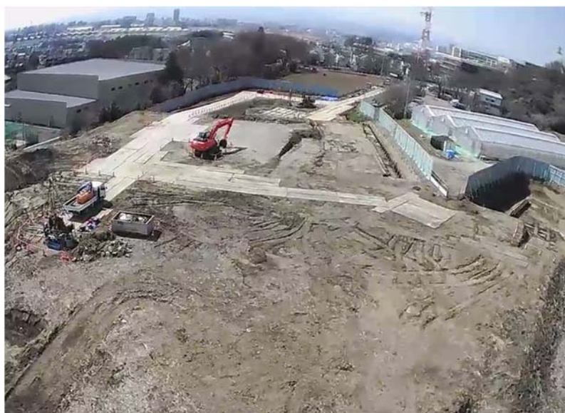
写真 3-4-6 施工状況 (平成 31 年 3 月時点当社HP公開)
