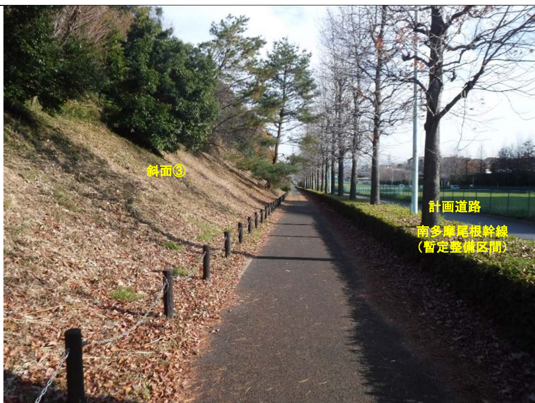
写真8. 5-2 斜面③（東側坑口付近）
