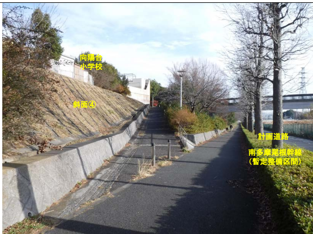
写真8.5-3 斜面④（向陽台小学校付近）
