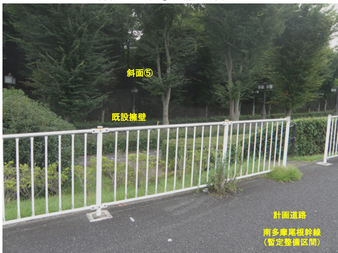
写真8.5-4 斜面⑤（縦谷戸大橋交差点付近）
