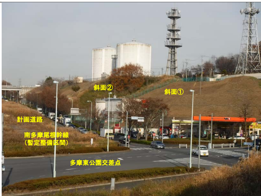
写真8. 5-1 斜面①②（多摩東公園交差点付近）
