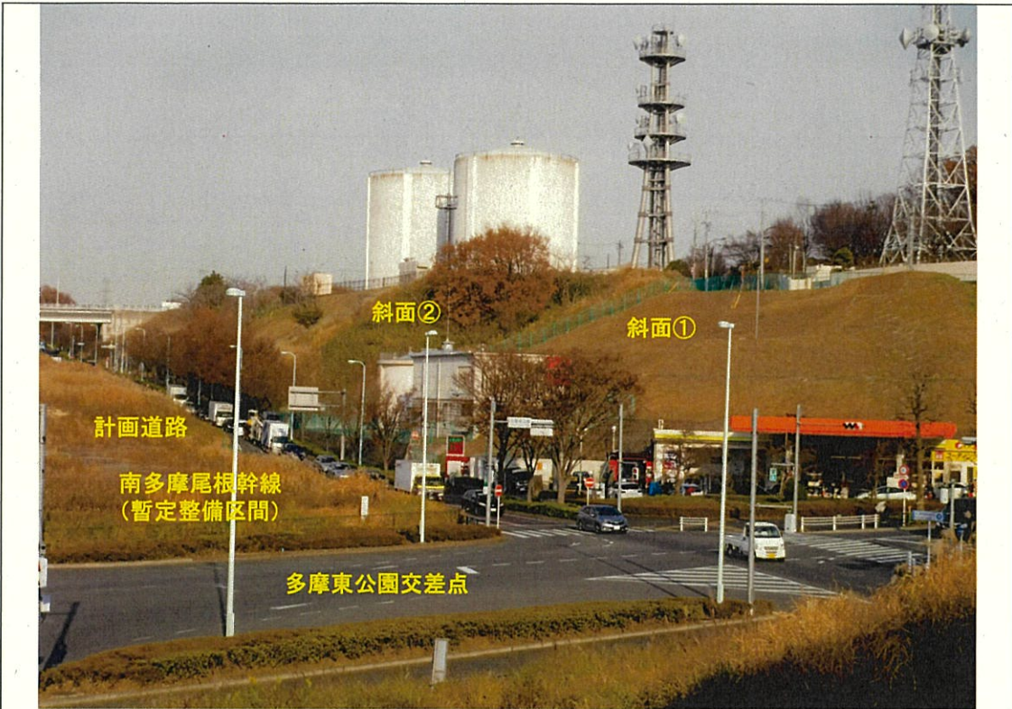
写真10.5-1 斜面①② (多摩東公園交差点付近)
