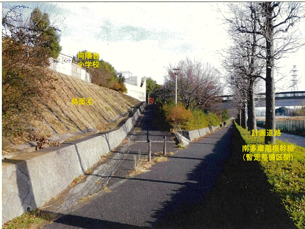
写真10.5-3 斜面④（向陽台小学校付近）
