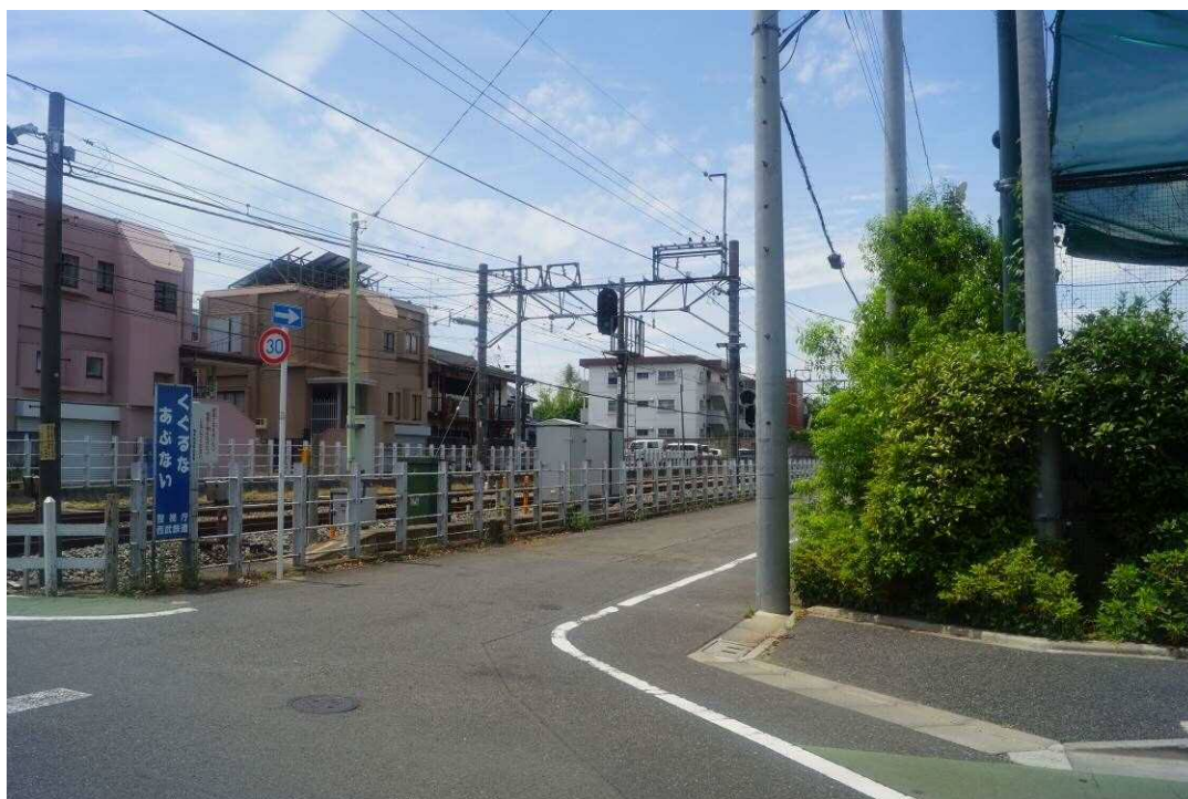
①現況：上石神井第3号踏切付近から西武新宿線の地平構造が視認され、線路・道路沿いには戸建て・集合住宅等が視認できる。
