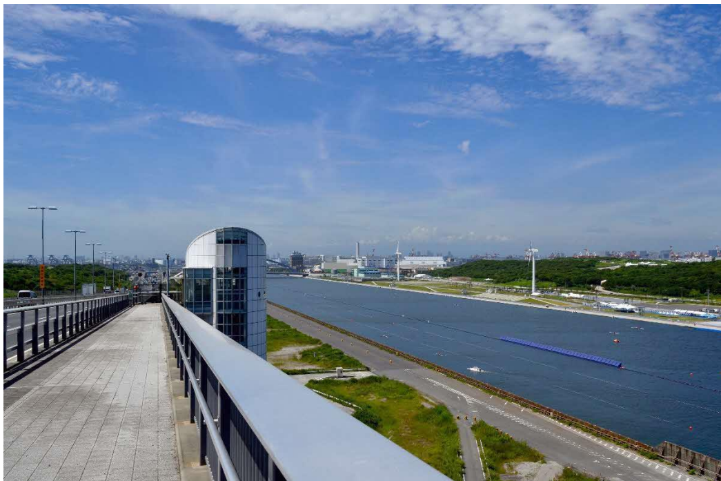
写真 8.5-2 (1) 地点2 東京ゲートブリッジからの景観 (現況)
