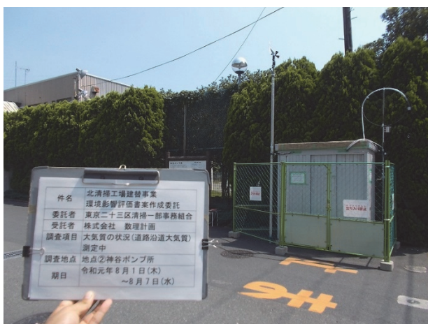
神谷ポンプ所 地点②
