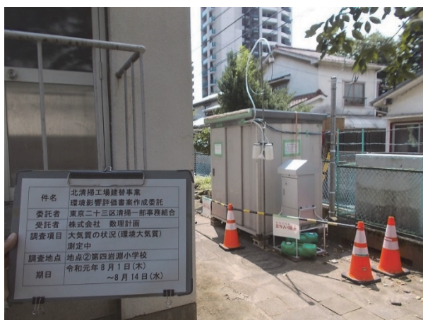
第四岩淵小学校 地点②
