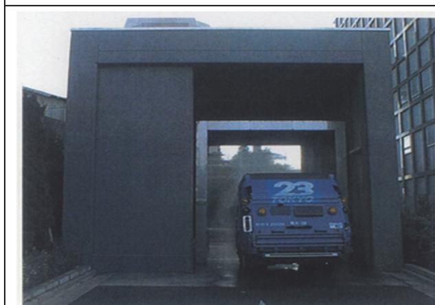
注) 主に車体外部及びタイヤに付着したごみを除去するためまわりのノズルから水を噴霧させている。
