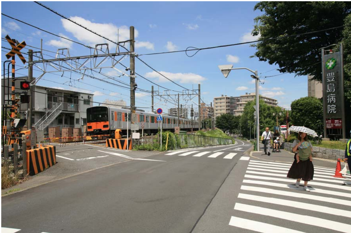
①現況：左手に東上本線第18号踏切が視認され、右手に豊島病院、中央付近には集合住宅等が視認できる。
