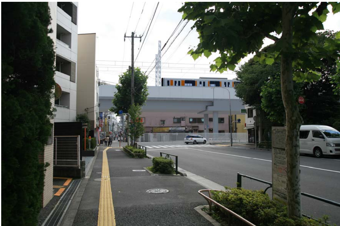
②将来：新たに高架橋が出現するが、周辺の建物を大きく超える高さではなく、周辺の建物と調和した都市的景観になるものと予測される。
