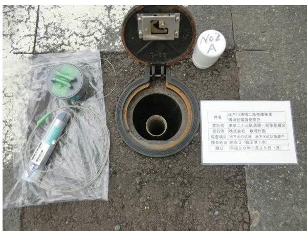
地点② (被圧地下水)
