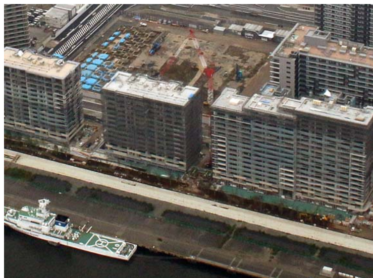
写真 3-1 環境保全のための措置の実施状況 (クレーン非使用時のブームの向き)
