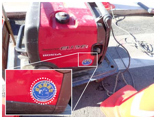
写真 2-4 環境保全のための措置の実施状況 (超低騒音型建設機械)
