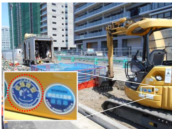
写真 2-1 環境保全のための措置の実施状況 (低騒音型建設機械)
