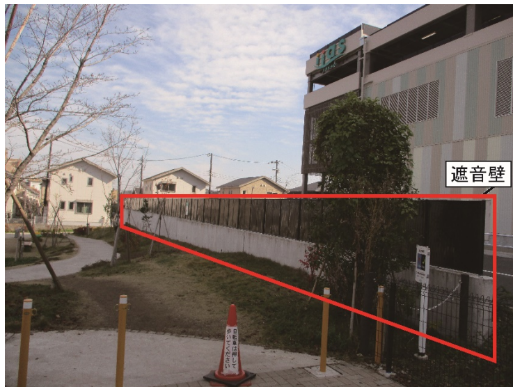
写真 6. 2-2 計画地北東側の遮音壁を設置
