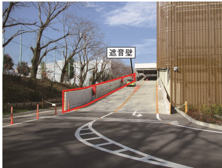
写真 6. 2-1 西側（小学校側）のスロープの擁壁
