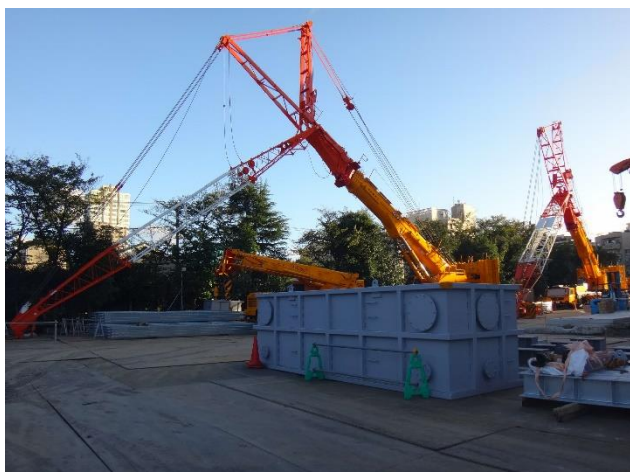
写真 25 クレーンブームの格納状況
