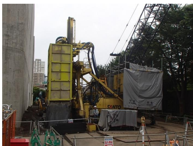
写真 21 山留め壁施行状況
