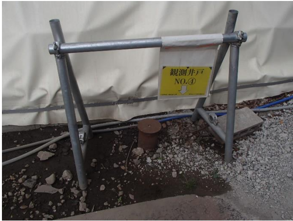
写真 23 観測井設置状況
