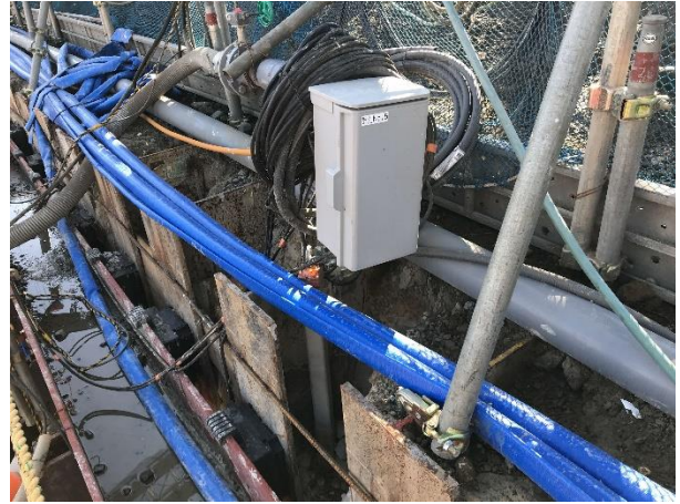
写真 24 地盤変位計設置状況
