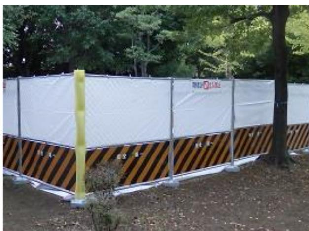
写真 17 汚染土壌の飛散防止措置
