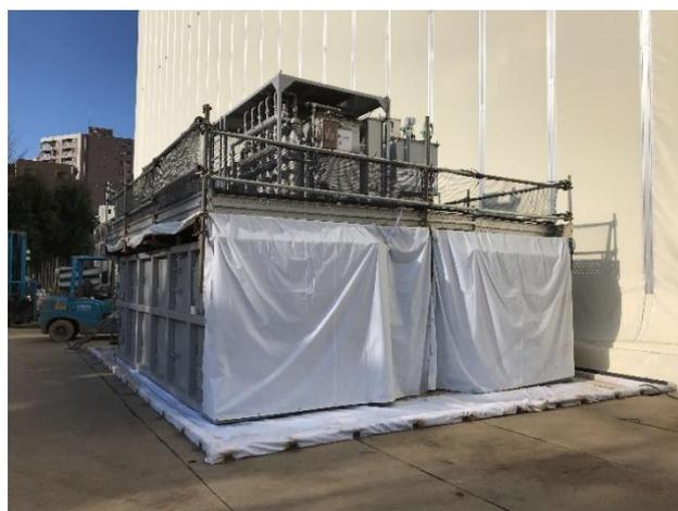
写真 20 仮設汚水処理設備
