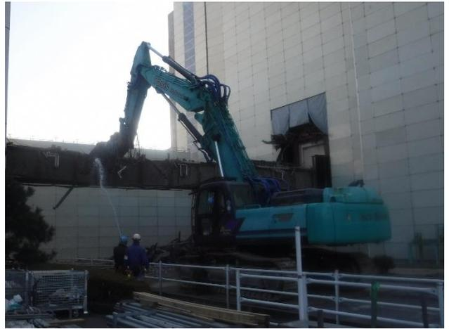
写真6 工事現場の散水状況
