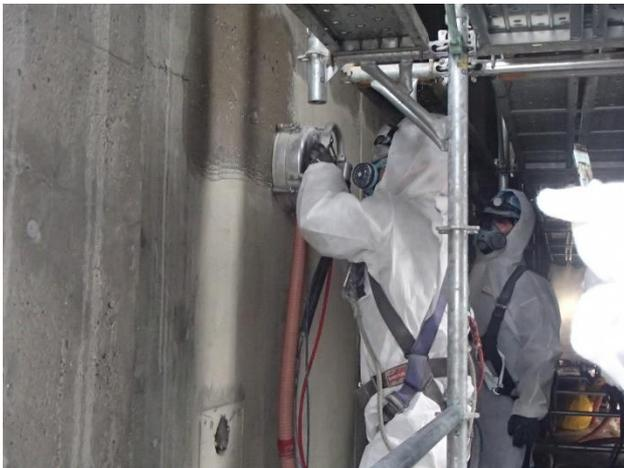
写真 13 アスベスト除去作業
