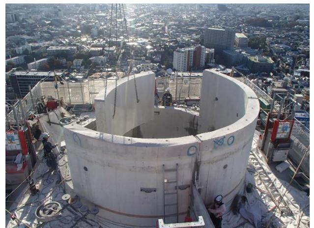
写真 16 ワイヤソーによる煙突解体状況
