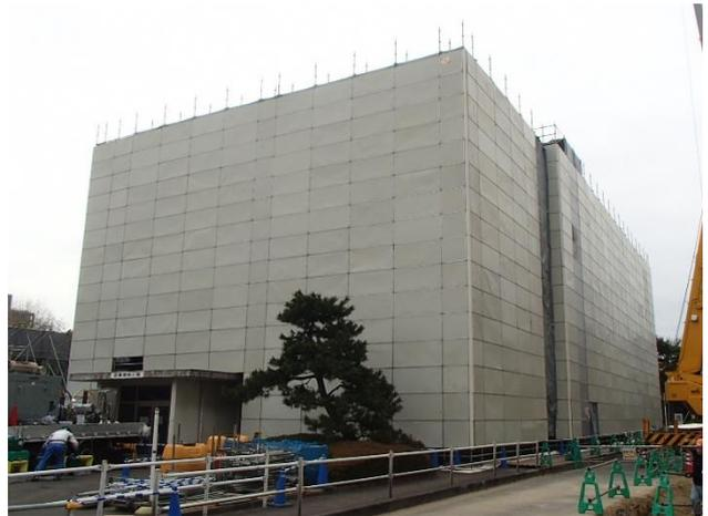
写真 12 アスベスト飛散防止対策
