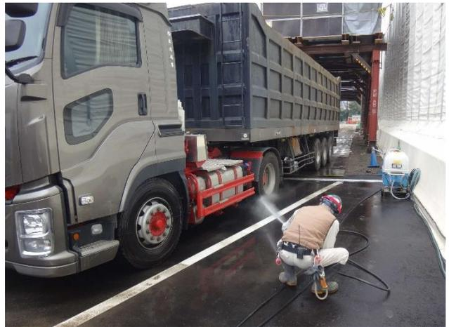
写真8 工事用車両の粉じん飛散防止対策
