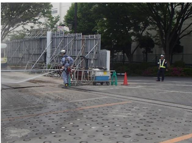
写真9 工事用車両出入口の清掃状況
