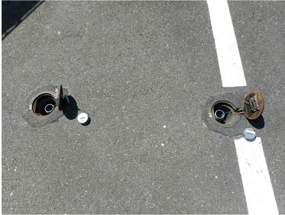
写真 5-2 観測井戸の設置状況 (St. 地 2)
