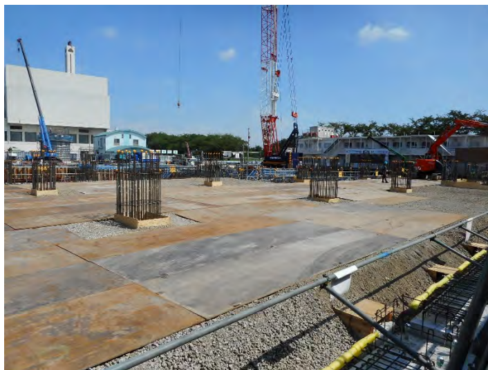
写真 3-5 鉄板敷の敷設状況
