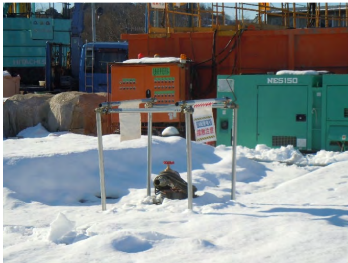
写真 3-2(1) ディープウェル設置状況
