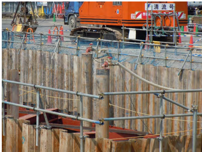
写真 3-2(2) ディープウェル設置状況
