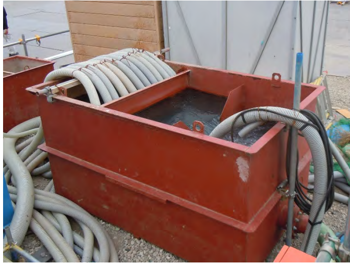
写真 3-3 沈砂池（ノッチタンク）の設置状況
