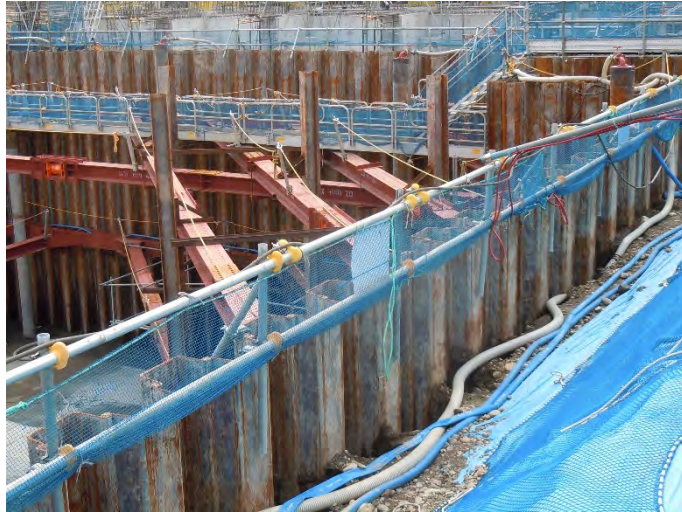
写真 3-1 シートパイル設置状況
