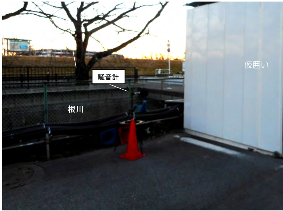
写真 2-1(1) 調査地点 (St. 騒振 1 敷地境界北東側) の状況
