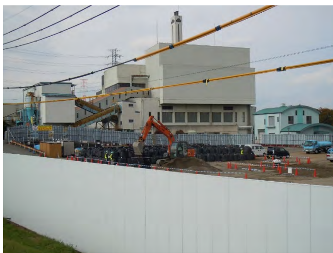
写真 2-6(2) 仮囲いの設置状況
