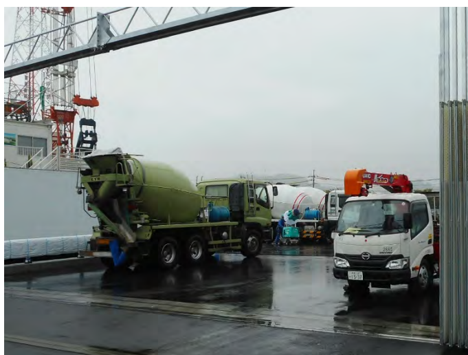
写真 2-9 対象事業実施区域での車両の待機の状況
