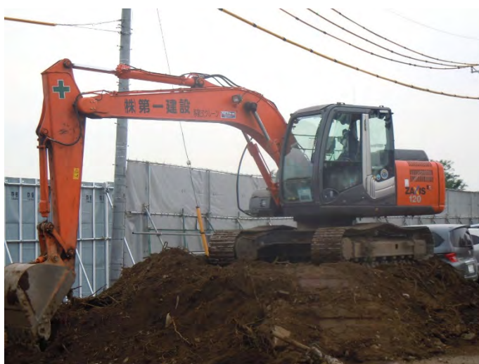
写真 2-7(1) 低騒音型の機械 (バックホウ ZAXIS120) (全景)
