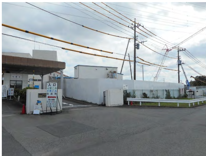
写真 2-6(3) 仮囲いの設置状況
