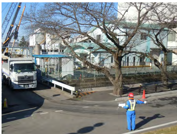
写真 2-8 交通誘導員の配置状況
