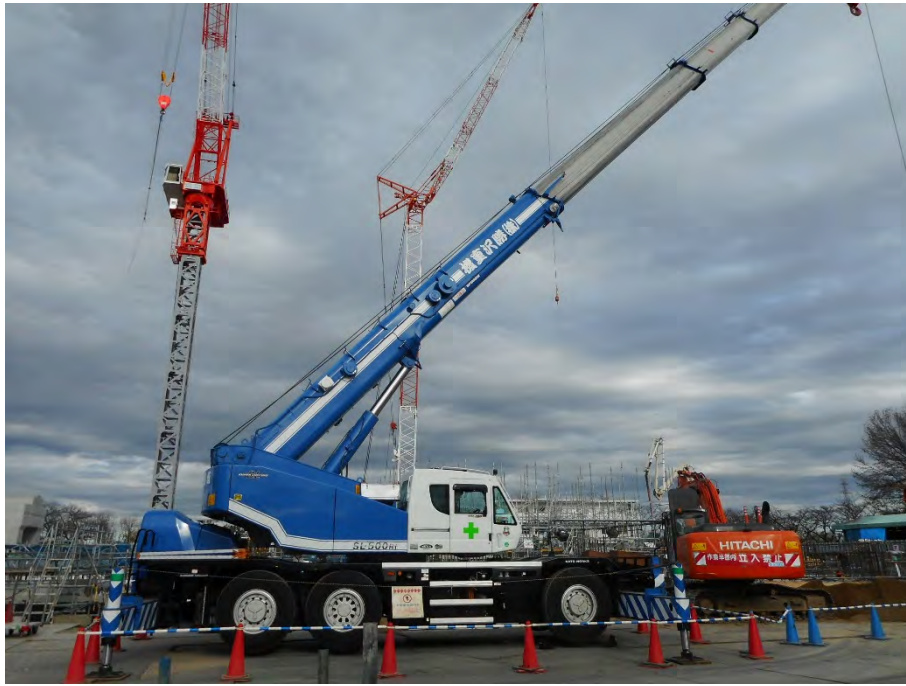
写真 2-2 建設機械の稼働状況（建築工事）
