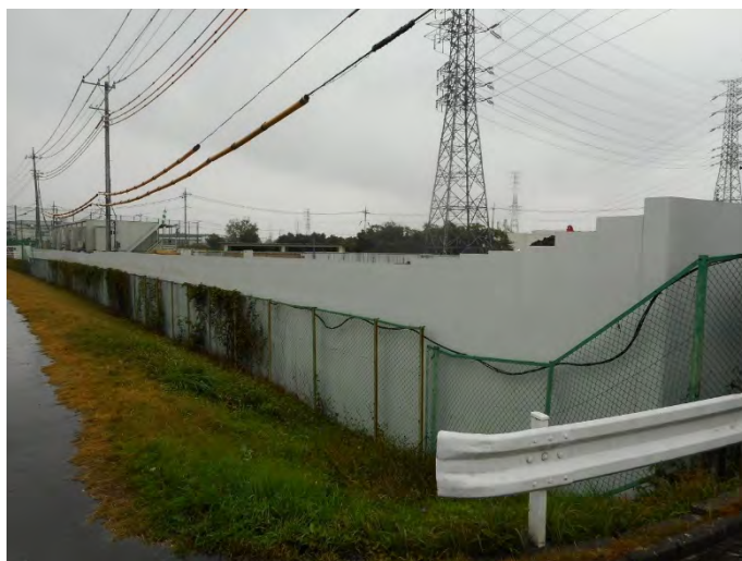
写真 2-6(4) 仮囲いの設置状況
