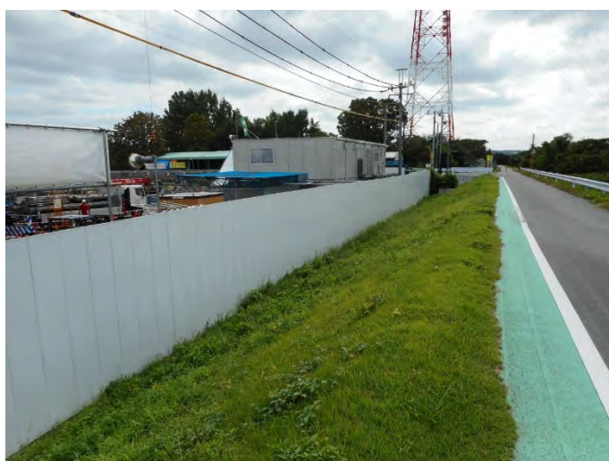
写真 2-6(1) 仮囲いの設置状況
