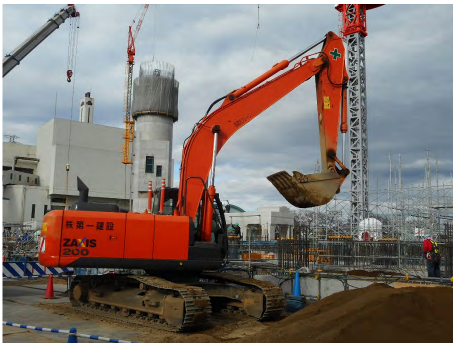
写真 2-3 建設機械の稼働状況（土工事）
