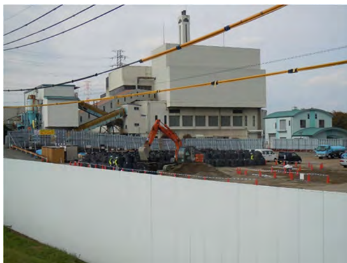
写真 2-4 工事の施行中の状況（仮囲いの設置状況）
