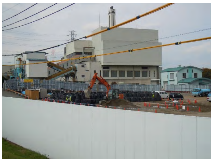
写真 1-4(2) 仮囲いの設置状況
