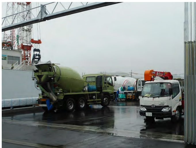
写真 1-10 対象事業実施区域での車両の待機状況
