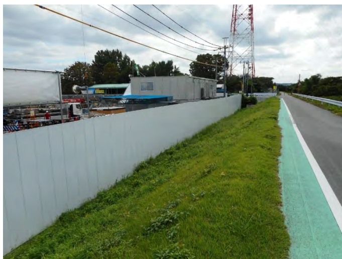
写真 1-4(1) 仮囲いの設置状況
