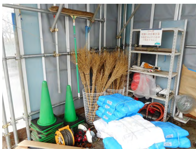
写真 1-9 工事用車両出入口の清掃用具
