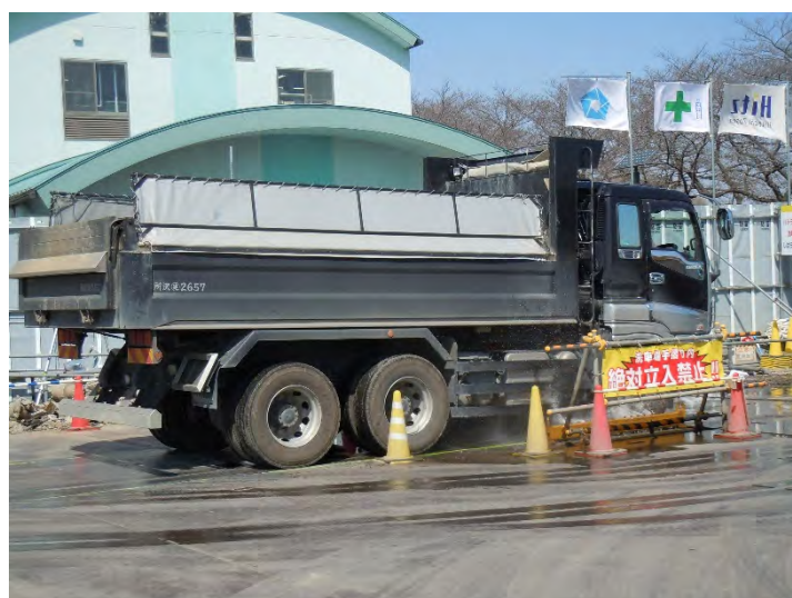
写真 1-8 ダンプトラックのタイヤ水洗いの状況
