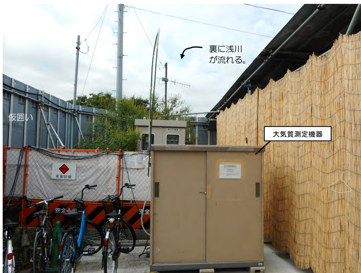
写真 1-1 調査地点（対象事業実施区域南側敷地境界付近）の状況
