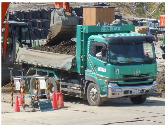
写真 1-7(1) ダンプトラックの土砂運搬の状況（土砂搬出時）
