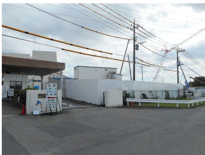
写真 1-4(3) 仮囲いの設置状況
