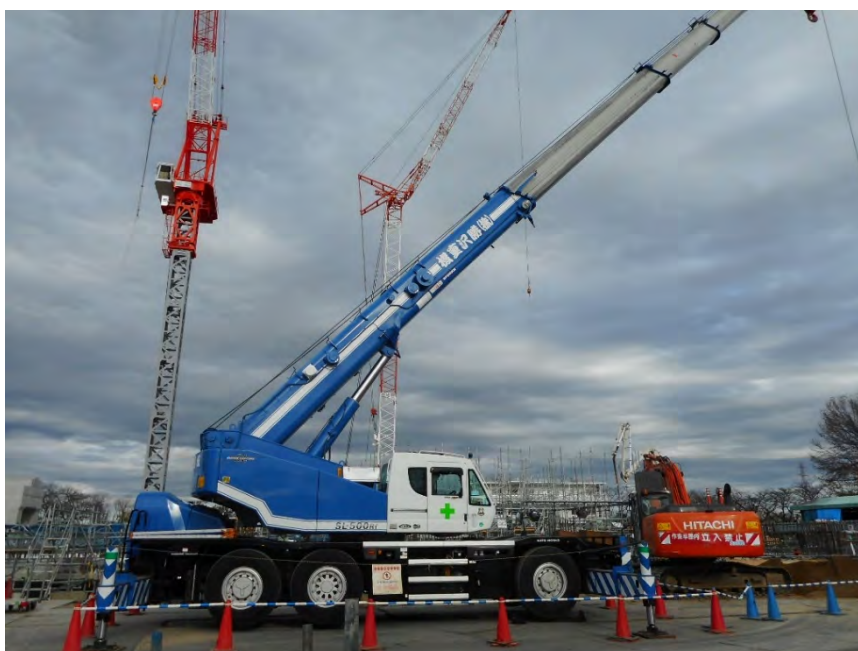
写真 1-2 建設機械の稼働状況（土工事）
