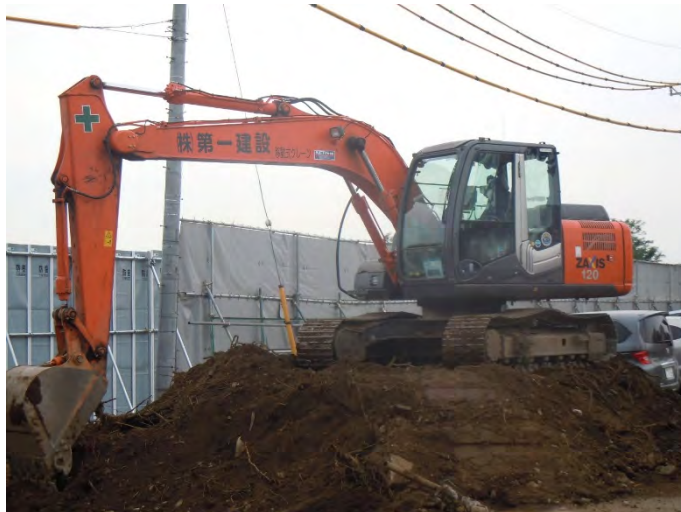
写真 1-5 (1) 排出ガス対策型の機械（バックホウ ZAXIS120）（全景）
