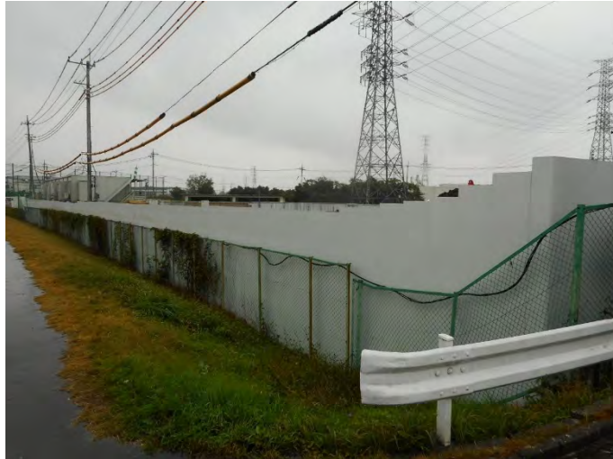
写真 1-4 (4) 仮囲いの設置状況
