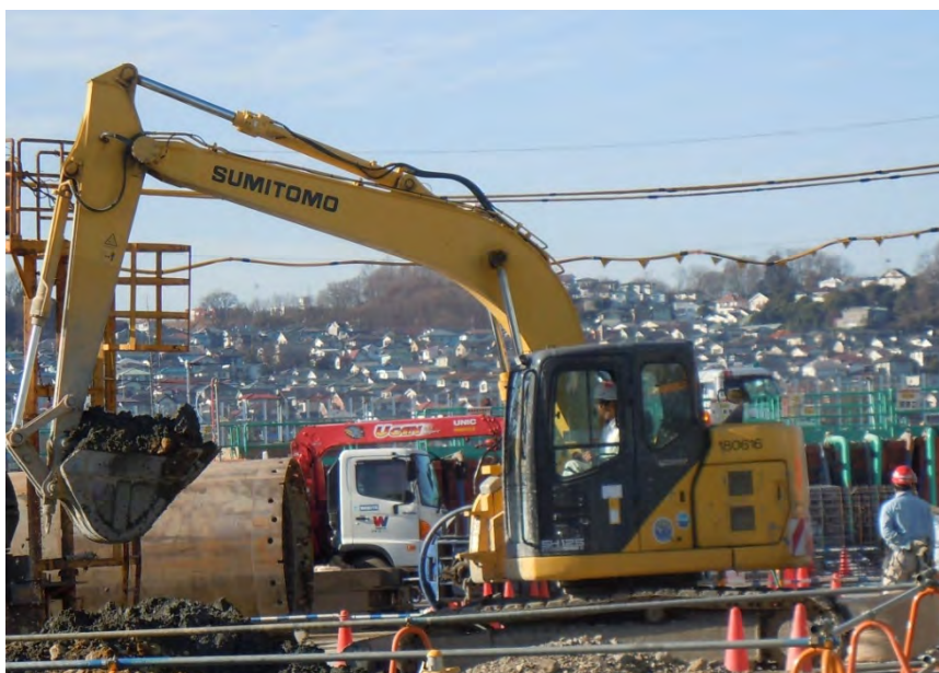
写真 1-3 建設機械の稼働状況（建築工事）
