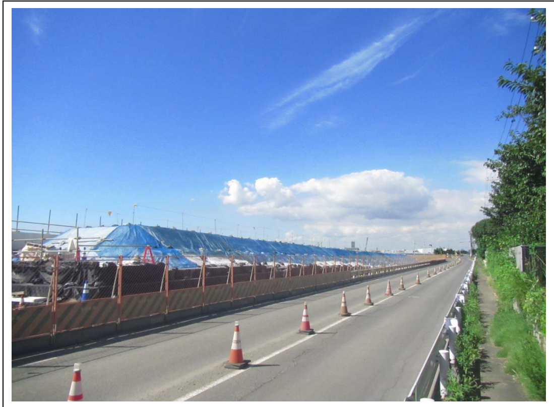
写真 9-3(1) 建設発生土の飛散防止状況（施工箇所_シート養生）
