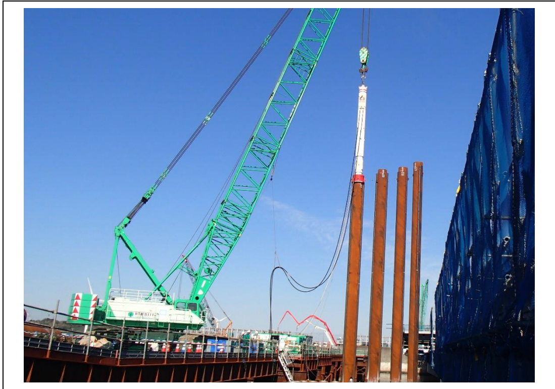
写真 8-1 (1) 鋼管矢板打設
