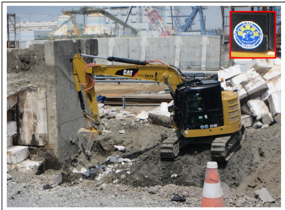
写真 7-2(2) 超低騒音型建設機械 (バックホウ 314EL)
