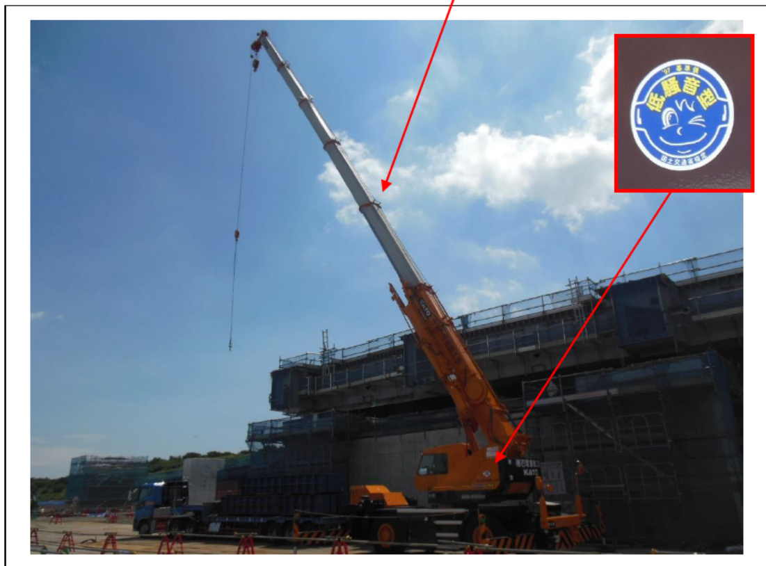
写真 7-2(1) 低騒音型建設機械 (ホイールクレーン KRM-35H-III)
