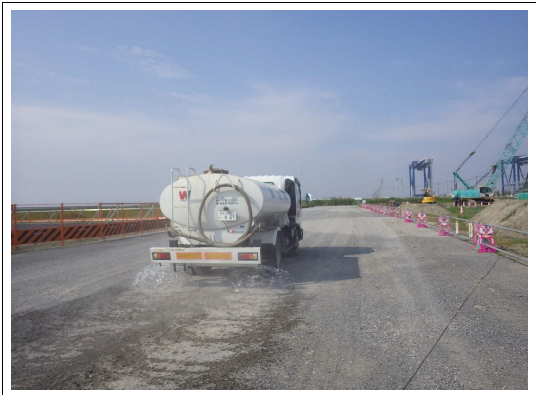
写真 7-5 粉じんの飛散防止対策（散水車）
