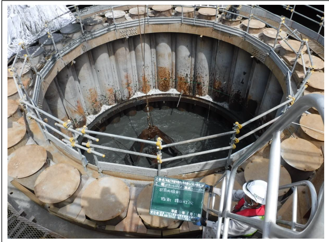
写真 6-2 鋼管矢板井筒内掘削（井筒内掘削）
