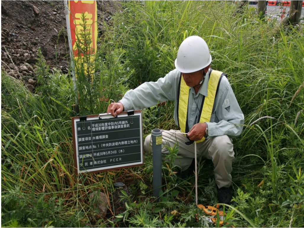
写真 6-1(1) 観測井の地下水位測定状況 (中防内)
