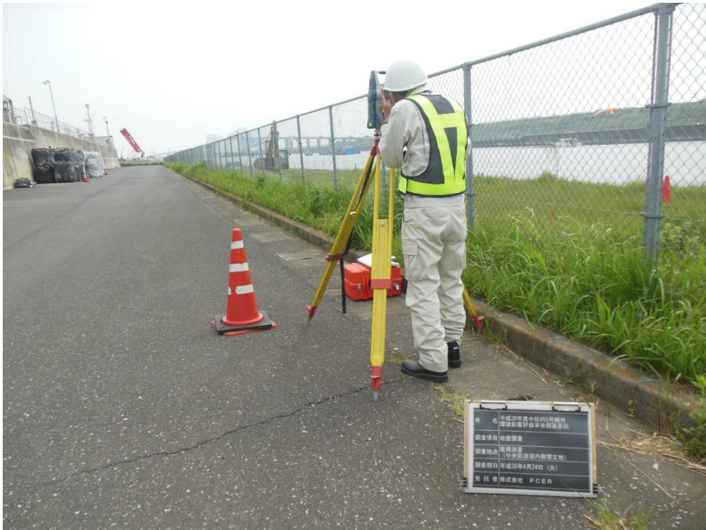
写真 5-1(1) 地盤調査状況（中防内）
