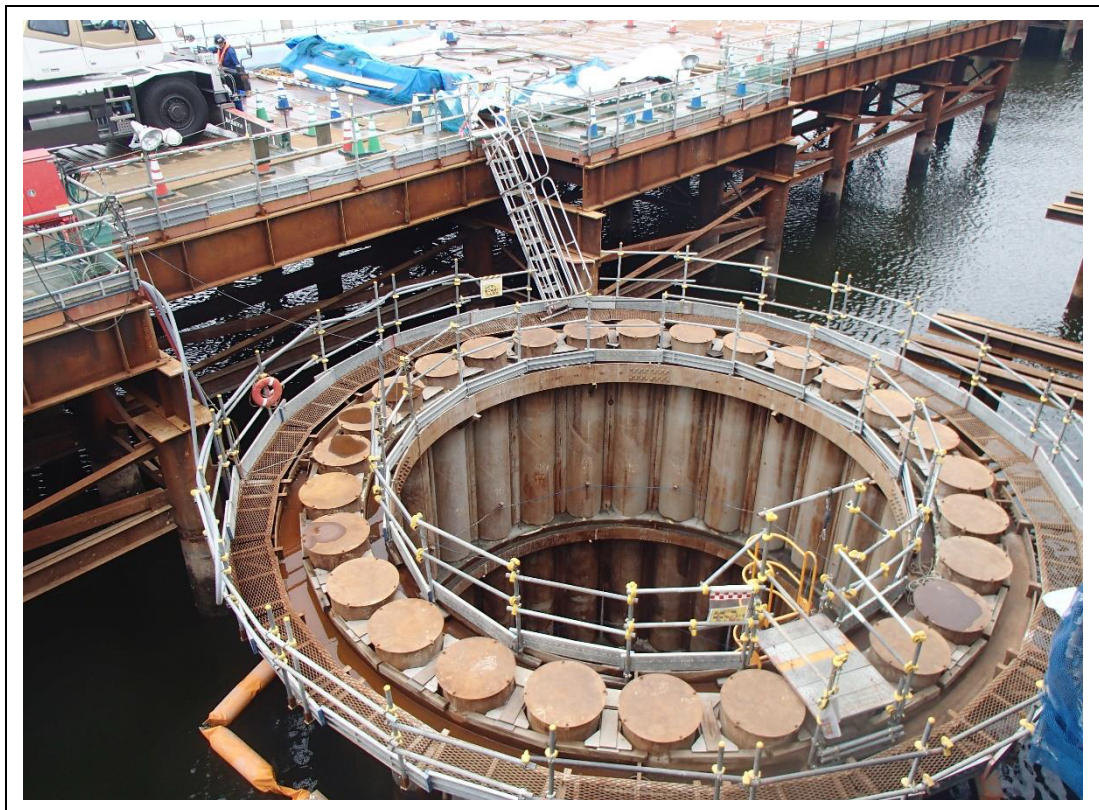
写真 5-4 鋼管矢板打設・井戸筒内掘削（井筒内支保工）
