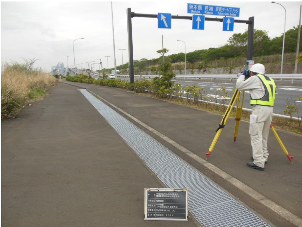
写真 5-1(2) 地盤調査状況（中防外）
