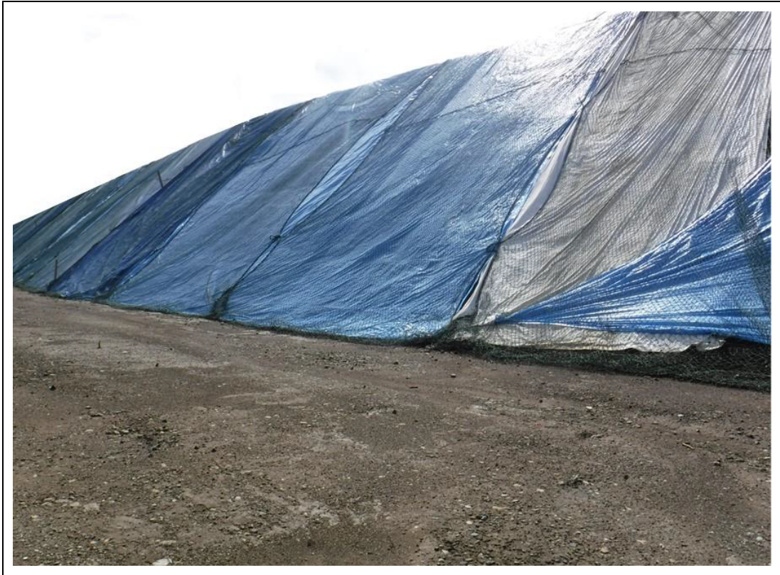
写真 4-2 建設発生土の飛散防止状況（シート養生）
