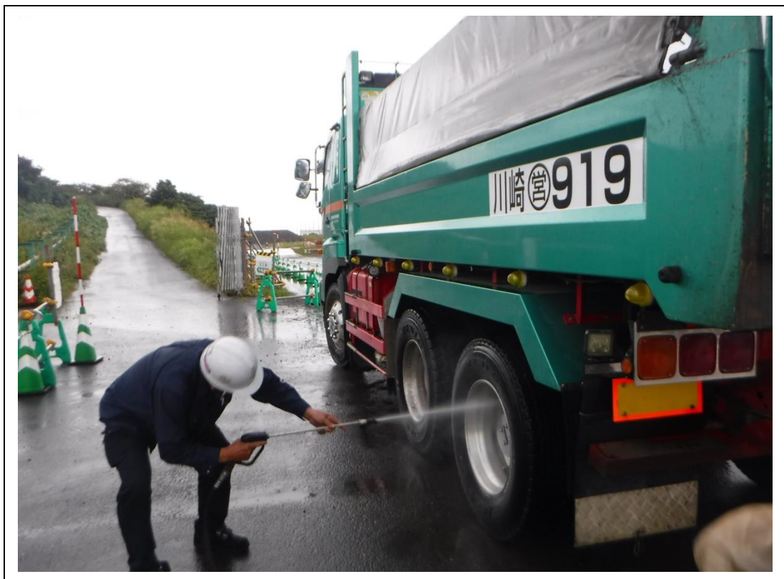
写真 4-1(2) 粉じん防止対策（タイヤの洗浄）
