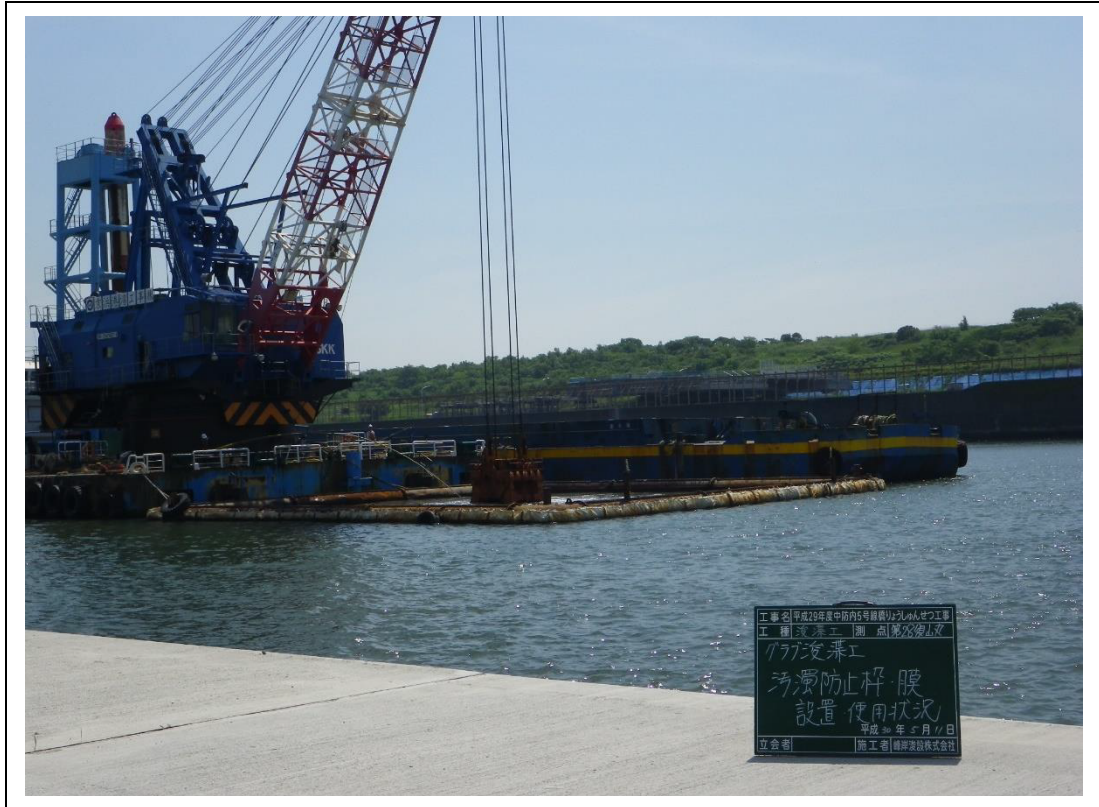
写真 3-1(1) 汚濁防止膜使用状況（グラブ浚渫船）
