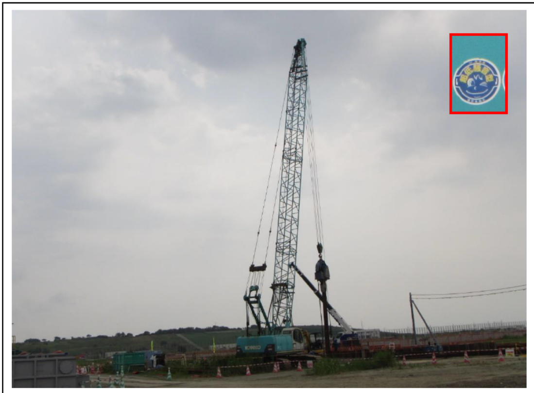
写真 2-4(2) 超低騒音型建設機械 (クローラクレーン 7055-2)
