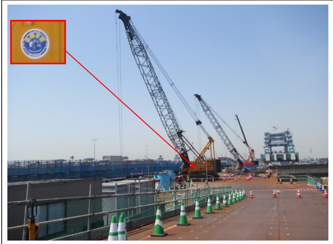
写真 2-1 (3) 低騒音型建設機械 (クローラクレーン CCH1200-5B)
