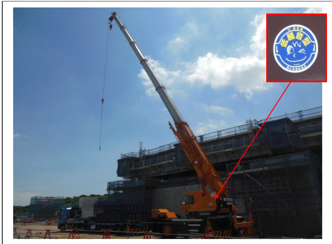
写真 2-1(1) 低騒音型建設機械（ホイールクレーン KRM-35H-III）
