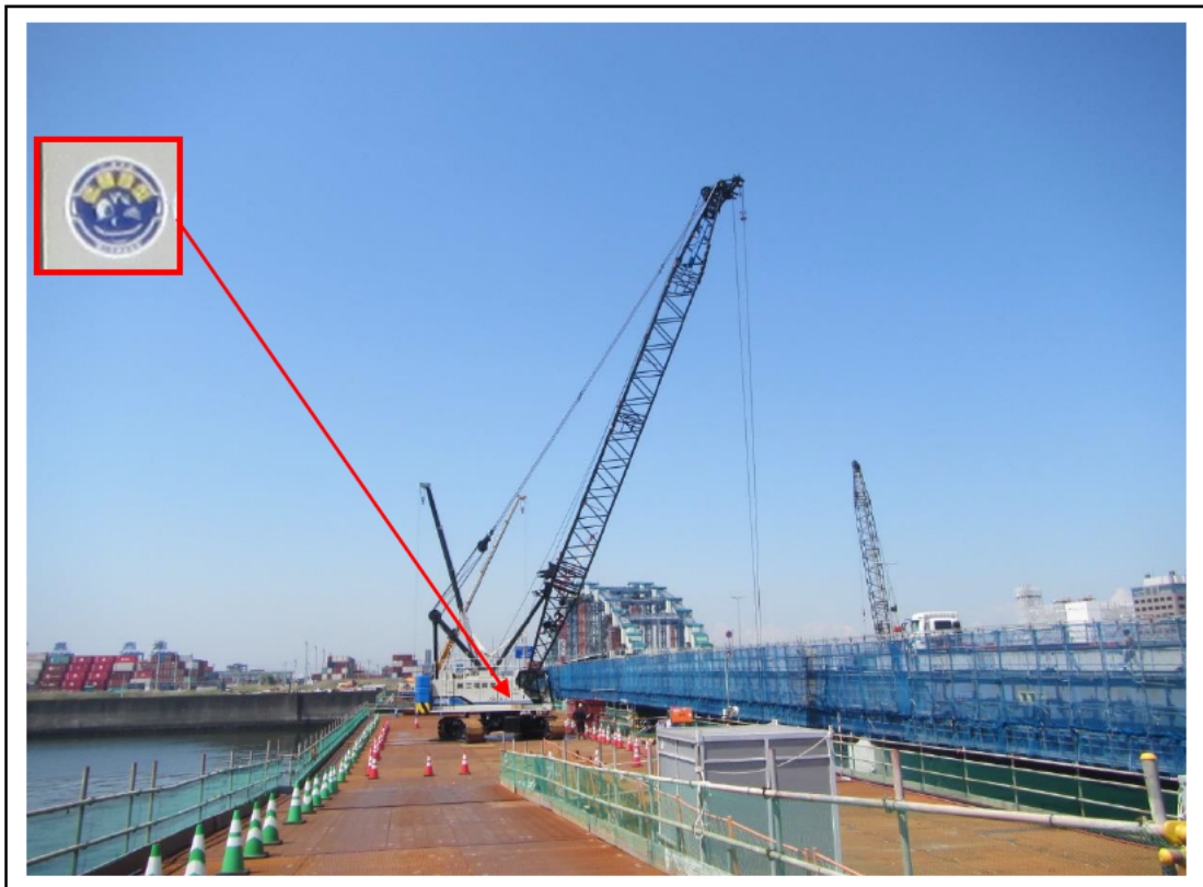
写真 2-1 (4) 低騒音型建設機械 (クローラクレーン SCX900-3C5)
