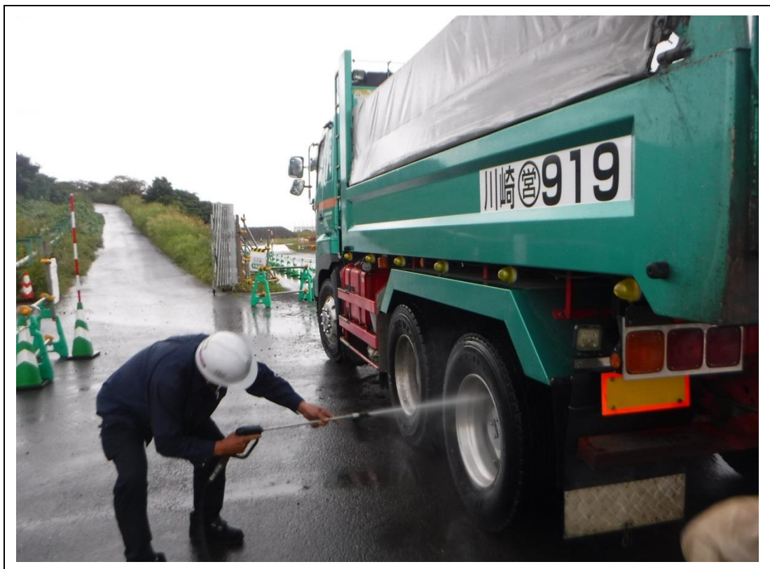
写真 1-5 ハイウォッシャーによるタイヤの洗浄
