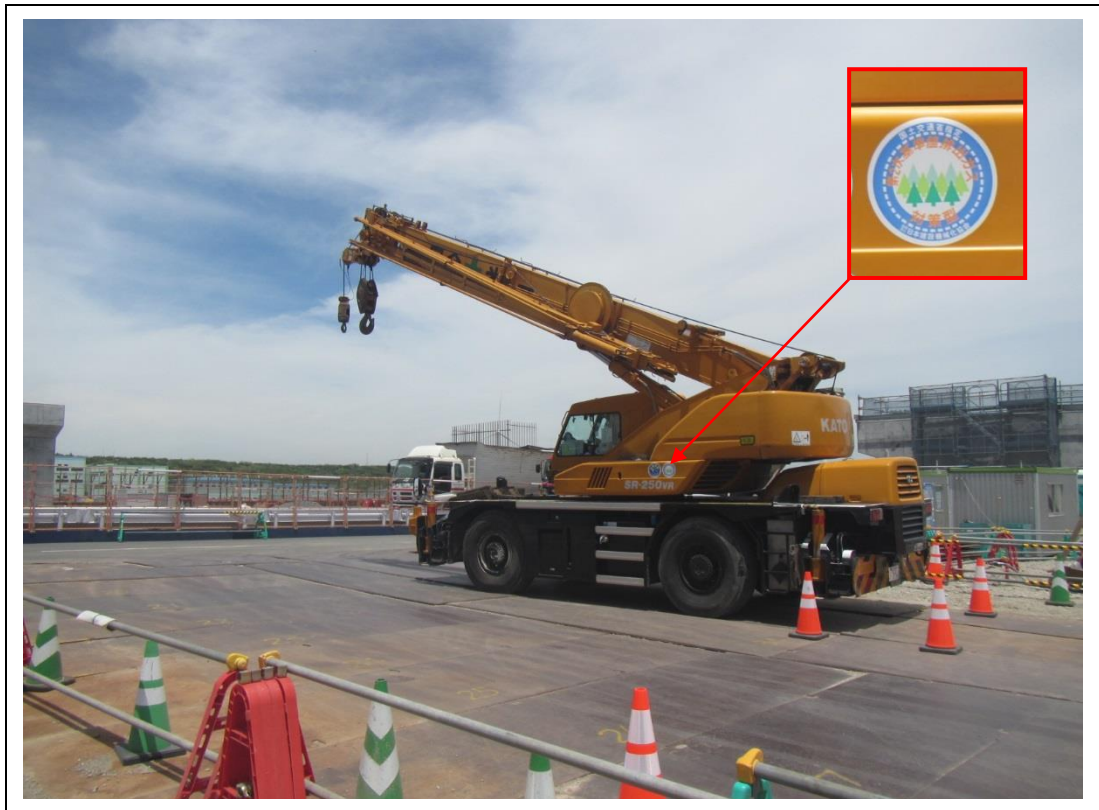
写真 1-1 (3) 排出ガス対策型建設機械（ホイールクレーン KR-25H-V5）
