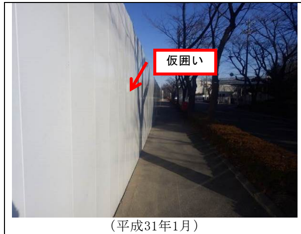
写真7-(2) 仮囲いの設置状況
