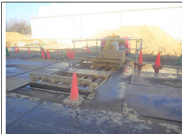
写真7-(8) タイヤ洗浄装置の設置状況
