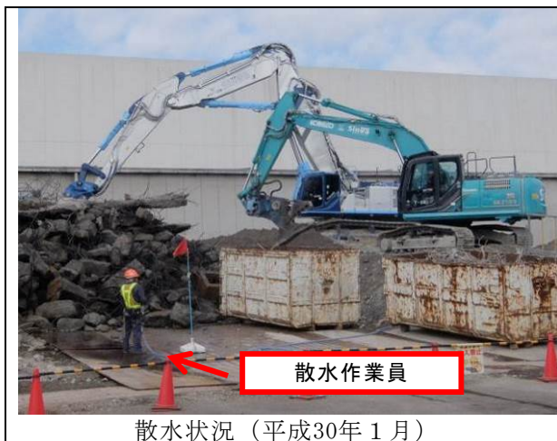
写真7-(4) 粉じんの飛散防止の状況
