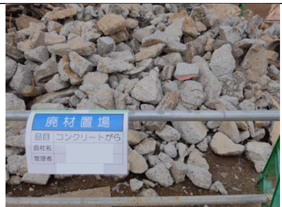
建設廃棄物の分別状況②（コンクリート塊） （平成31年1月）
