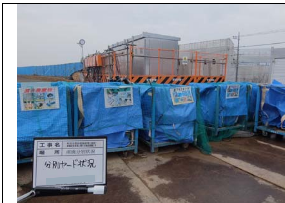
建設廃棄物の分別状況①（分別廃棄物） （平成31年1月）
