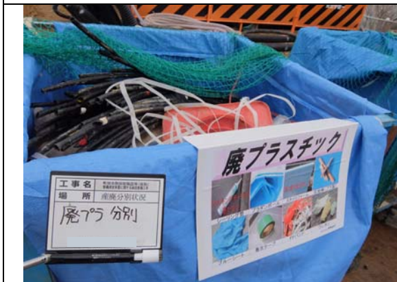
建設廃棄物の分別状況③（廃プラスチック類） （平成31年1月）
