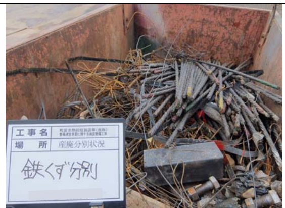
建設廃棄物の分別状況④（金属くず） （平成31年1月）
