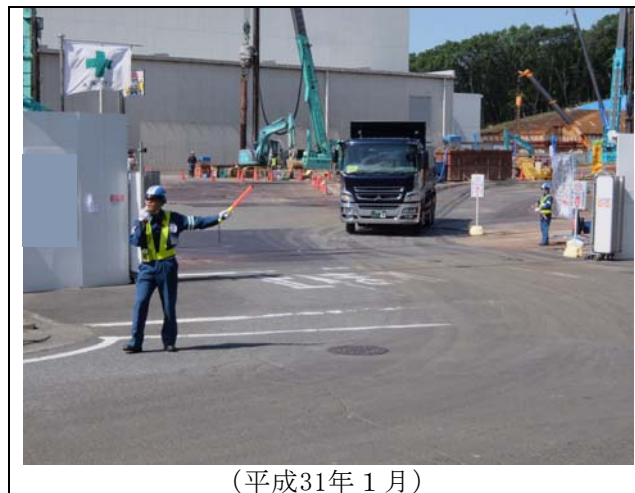
写真5-(2) 交通整理員の配置状況
