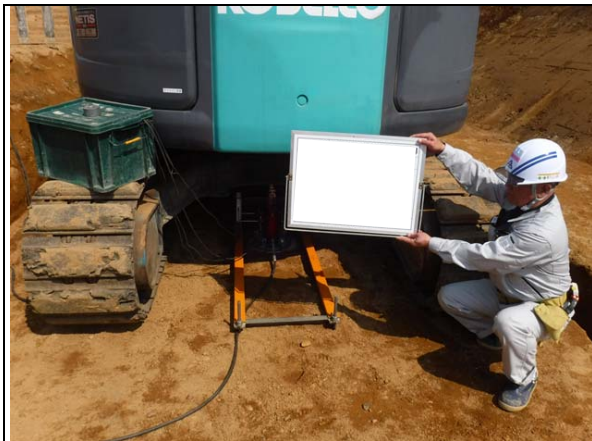
平盤載荷試験(平成30年3月)
