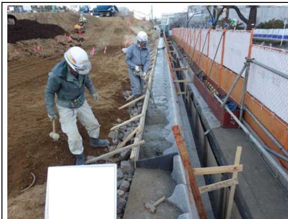
裏込めの様子(平成30年12月)
