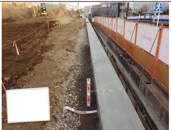
砕石の使用の様子(平成30年12月)
