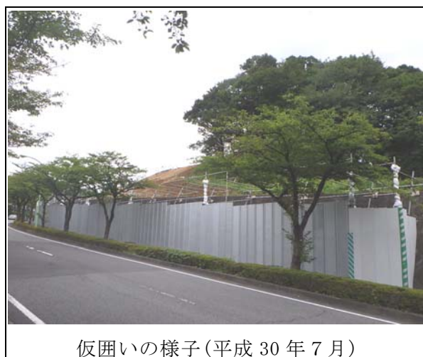
写真 3-(3) 落石防止措置の実施状況
