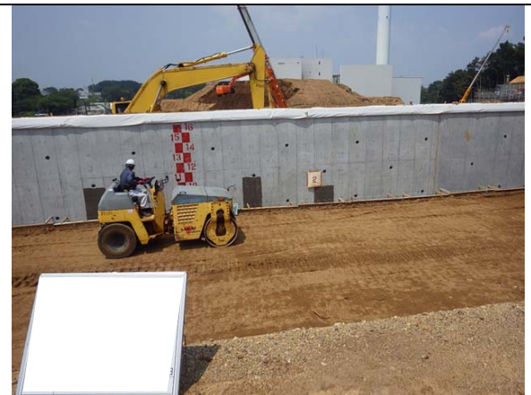
埋戻し転圧状況(平成30年7月)
