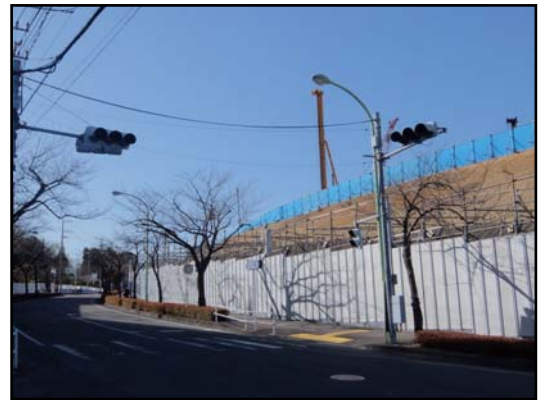
擁壁側からの眺め
