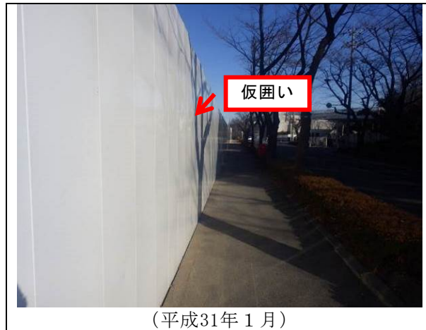
写真1-(2) 仮囲いの設置状況
