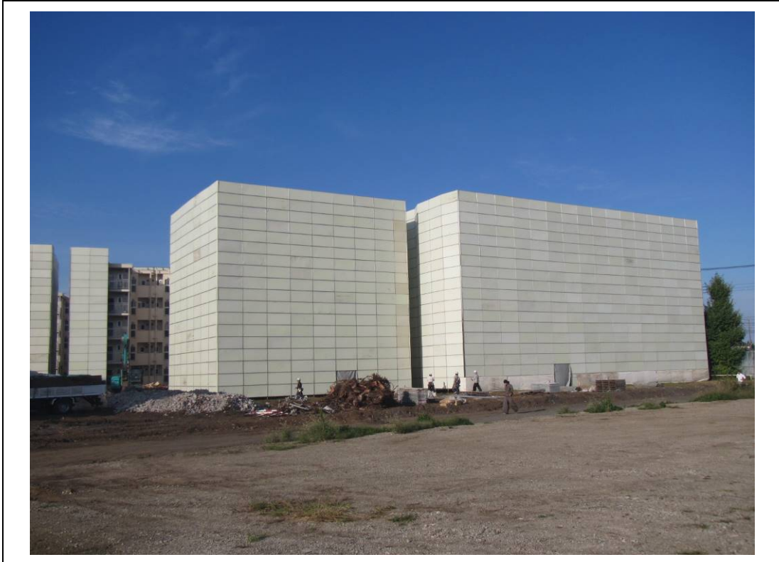
写真 2-9(1) 工事区域の防音パネル設置状況【除却】
