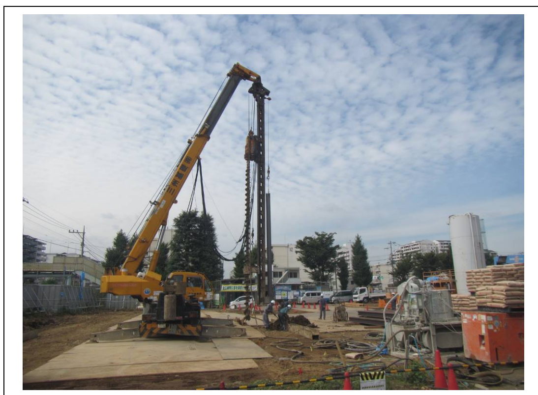
写真 2-8 プレボウリング工法による山留工事【後期第 1 期(後期)】
