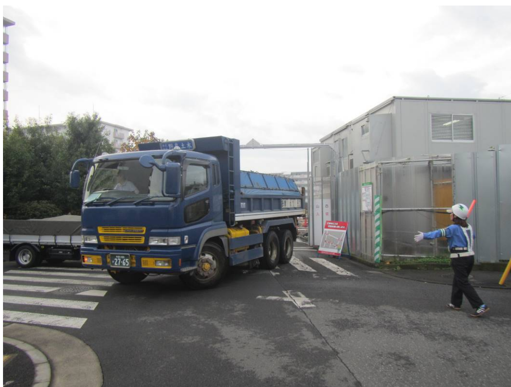
写真 2-16(2) 交通誘導の状況（工事用車両出入口）【後期第 1 期（後期）】
