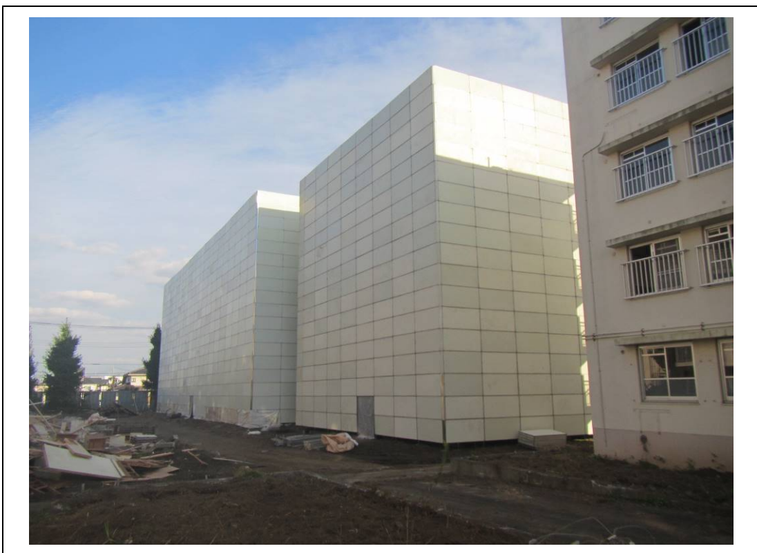
写真 2-9(2) 工事区域の防音パネル設置状況【除却】
