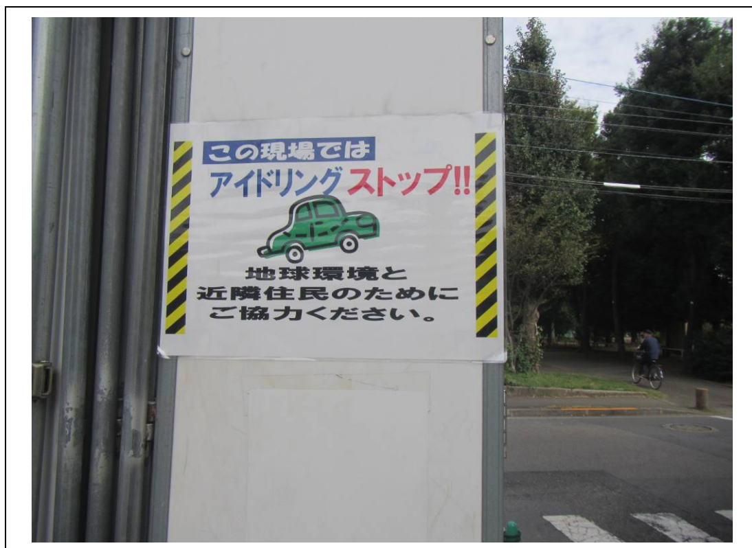
写真 2-13(1) アイドリングストップ看板設置状況【後期第 1 期(前期)①②】
