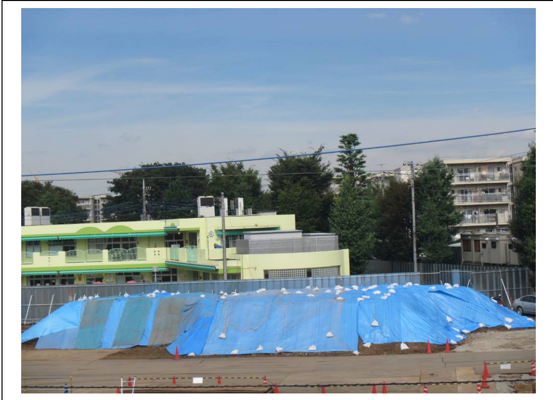
写真 2-11 建設発生土の仮置き状況【後期第 1 期(後期)】
