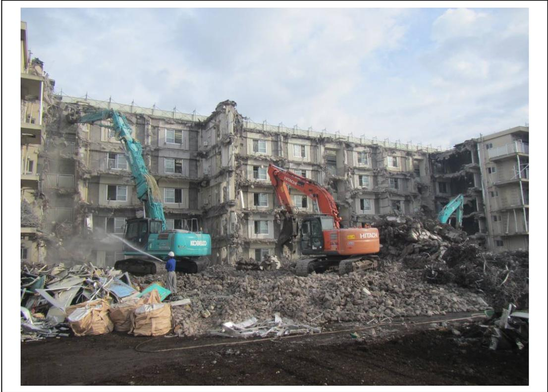
写真 2-3 除却工事における油圧破碎機の使用状況【除却】
