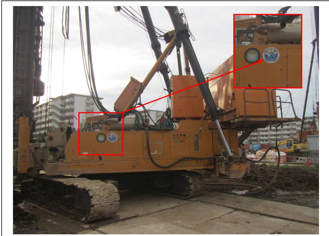
写真 2-1(1) 低騒音型建設機械の使用状況【後期第1期(後期)】: 杭工事[杭打機]
