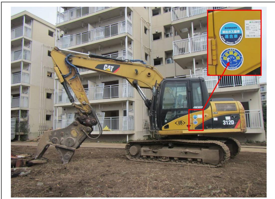
写真 2-1(2) 低騒音型建設機械の使用状況【除却】: 躯体解体[油圧破碎機]
