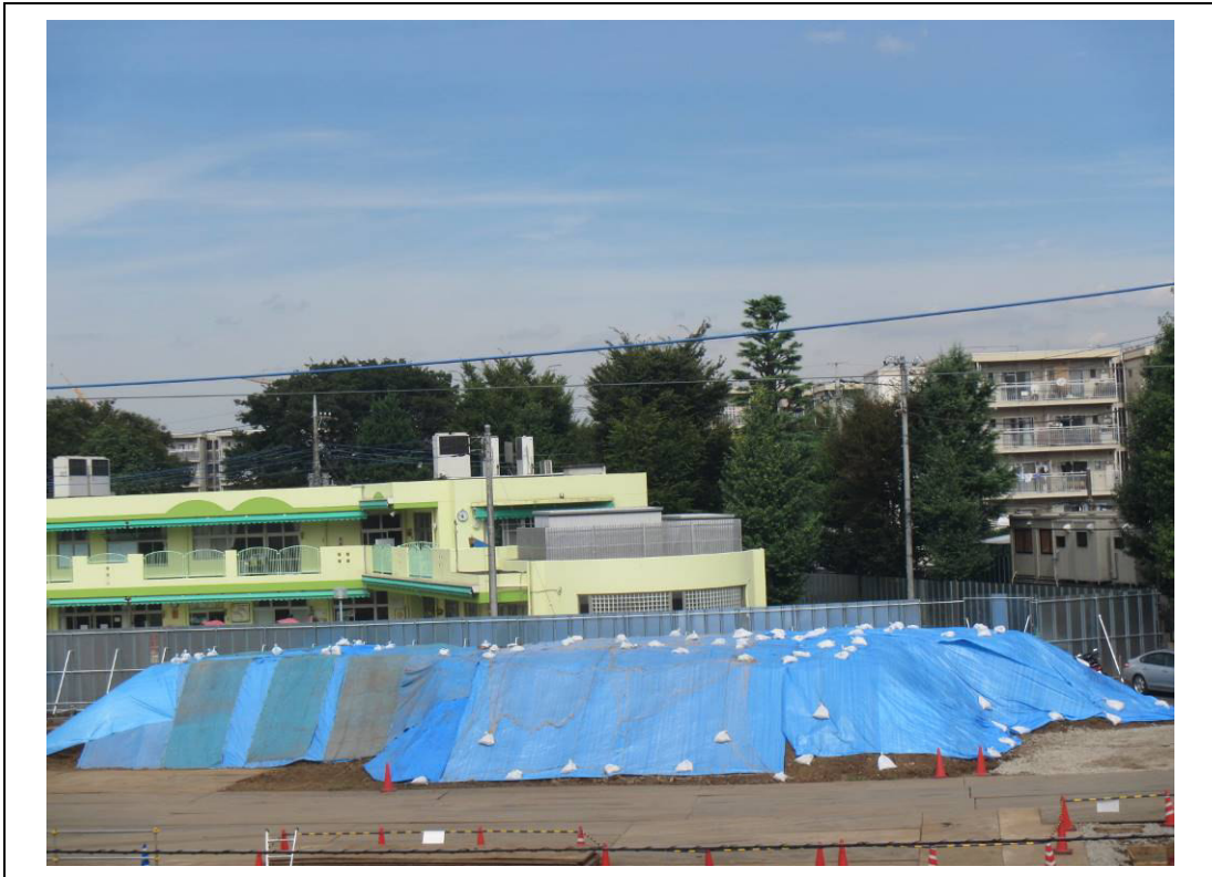
写真 1-8 建設発生土の仮置き状況【後期第 1 期(後期)】
