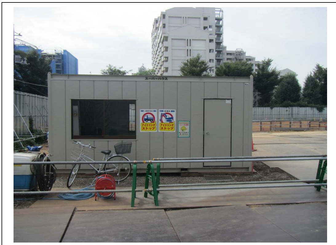
写真 1-11 アイドリングストップ看板の設置状況【後期第 1 期(前期②)】
