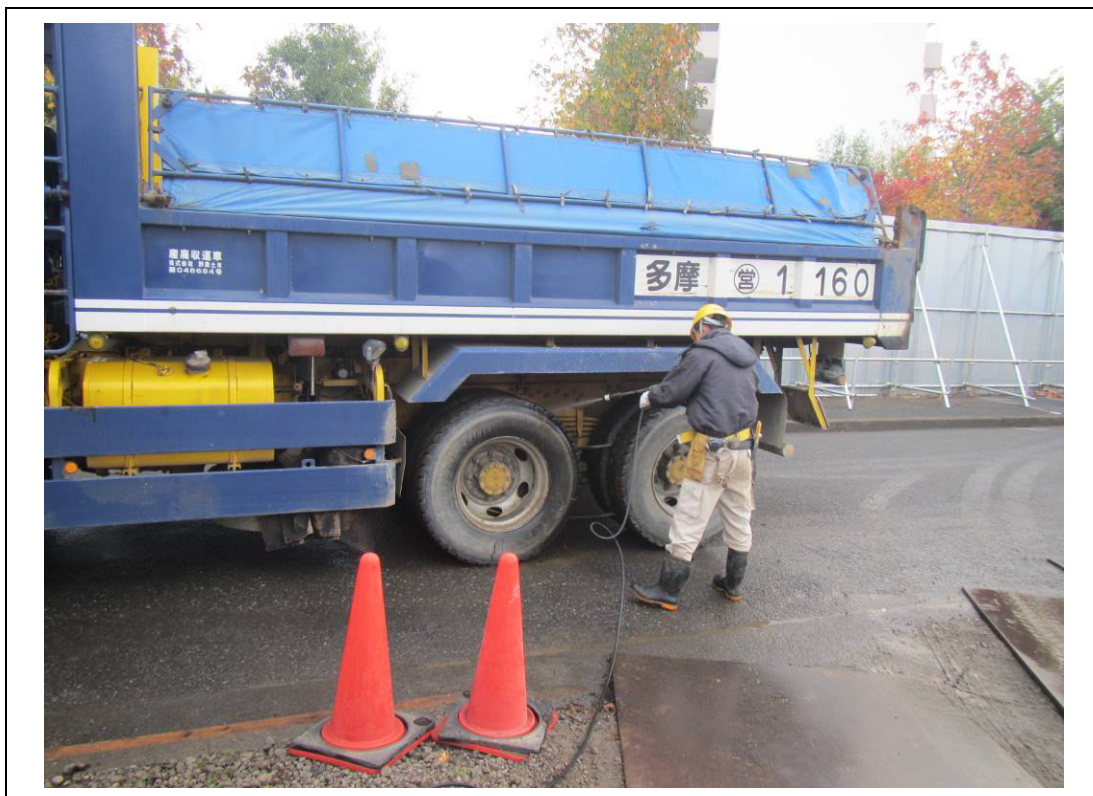
写真 1-10(1) 土砂搬出時のタイヤ洗浄【後期第 1 期(後期)】
