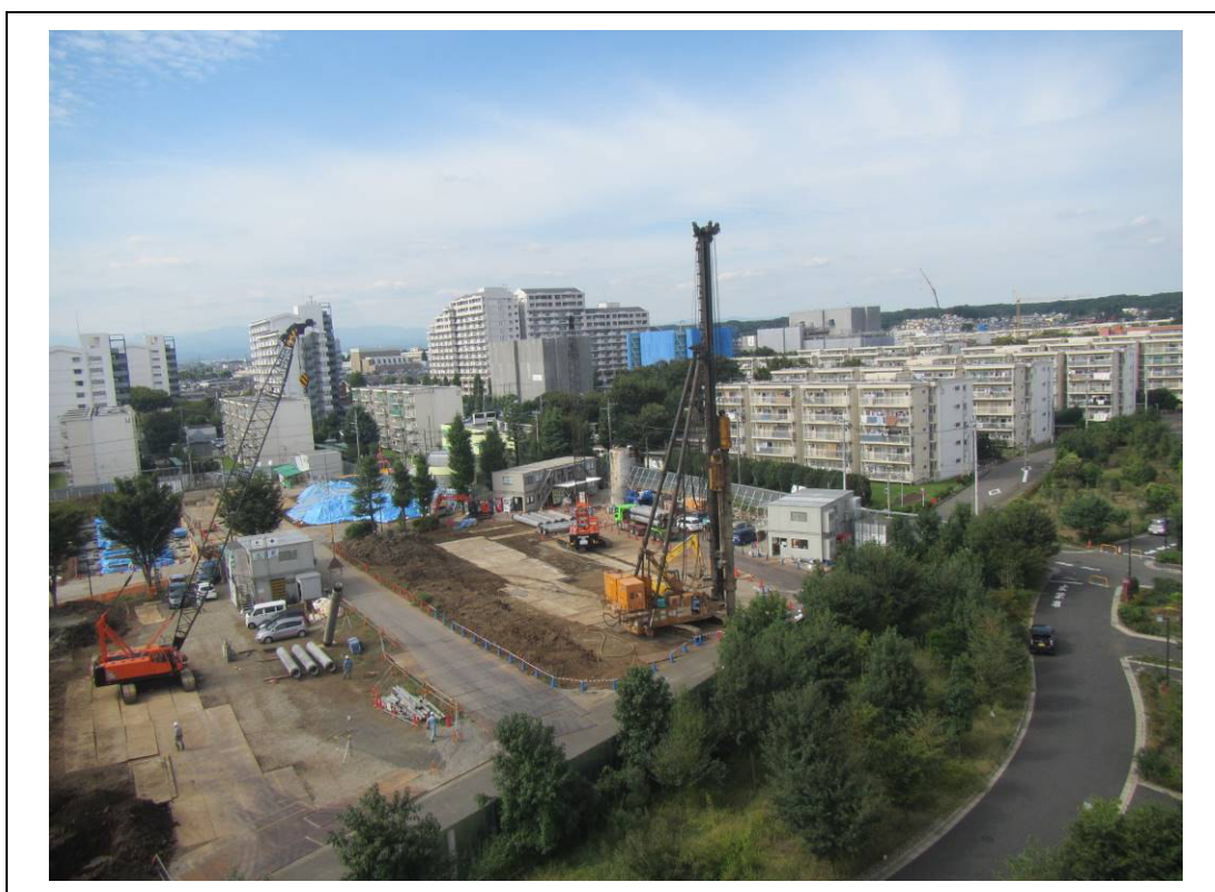
写真 1-10(2) 場内鉄板の敷設状況【後期第 1 期(後期)】
