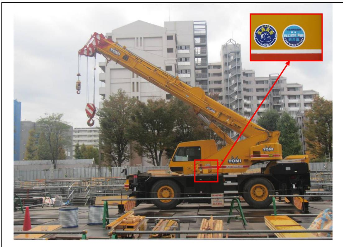
写真 1-1 (2) 排出ガス対策型建設機械の使用状況
