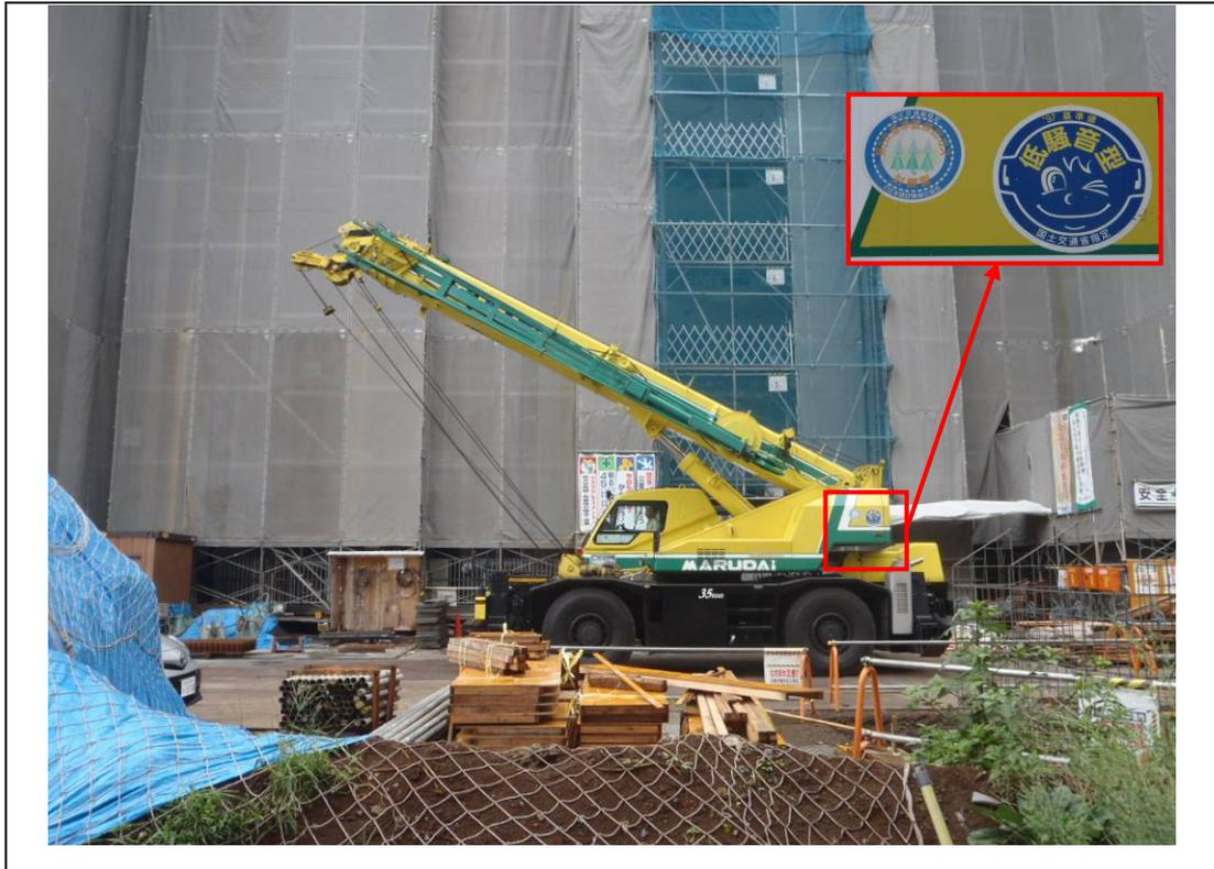
写真 1-1 (3) 排出ガス対策型建設機械の使用状況
