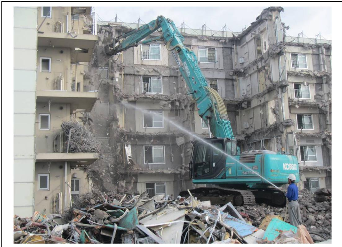
写真 1-5(1) 躯体解体工事における散水の状況【除却】
