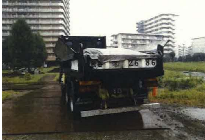
写真 4-1 建設発生土の搬出状況
