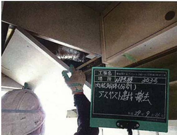
写真 3-2 石綿含有建材の解体状況(除却工事時)
