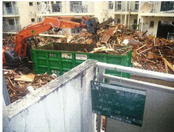
写真 3-1 品目別積み込み状況 (除却工事時)
