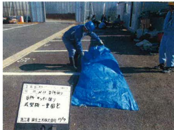
写真 3-2 石綿含有建材の解体状況(除却工事時)
