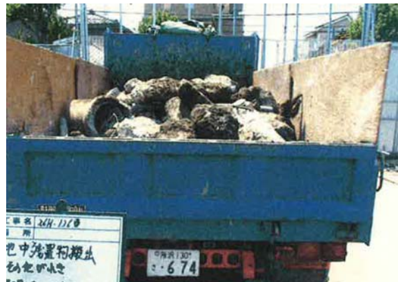
写真 3-3 建設廃棄物の分別積み込み状況(計画建築物の建設時)
