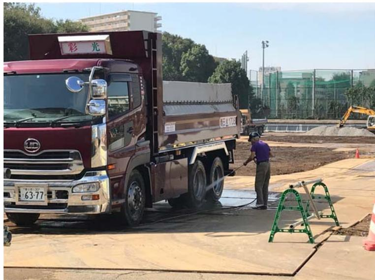
写真 1-3 工事用車両のタイヤ洗浄状況
