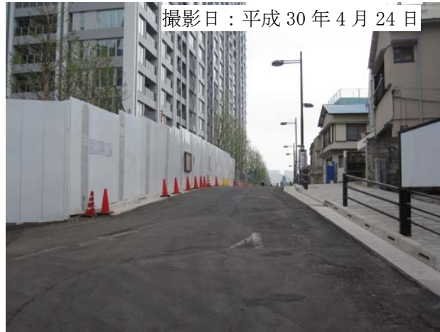
写真 6-2 仮囲い設置状況
