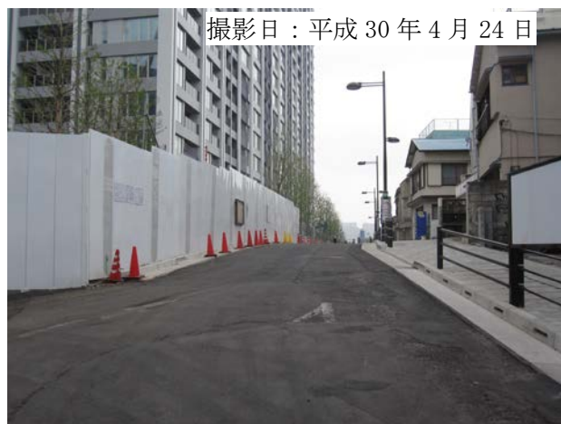
写真 7-2 仮囲い設置状況
