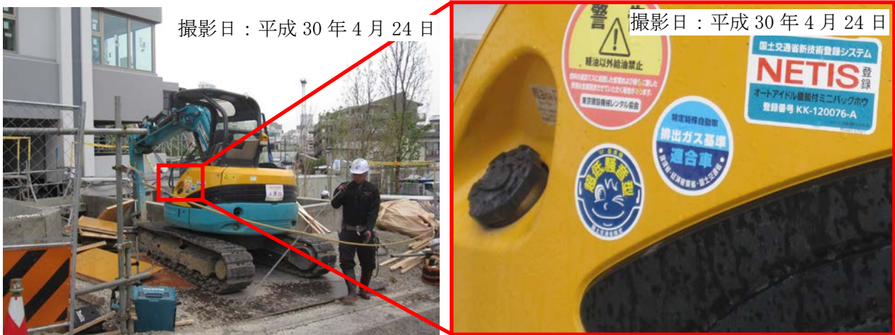
写真 6-1(1) 排出ガス対策型建設機械の使用状況
