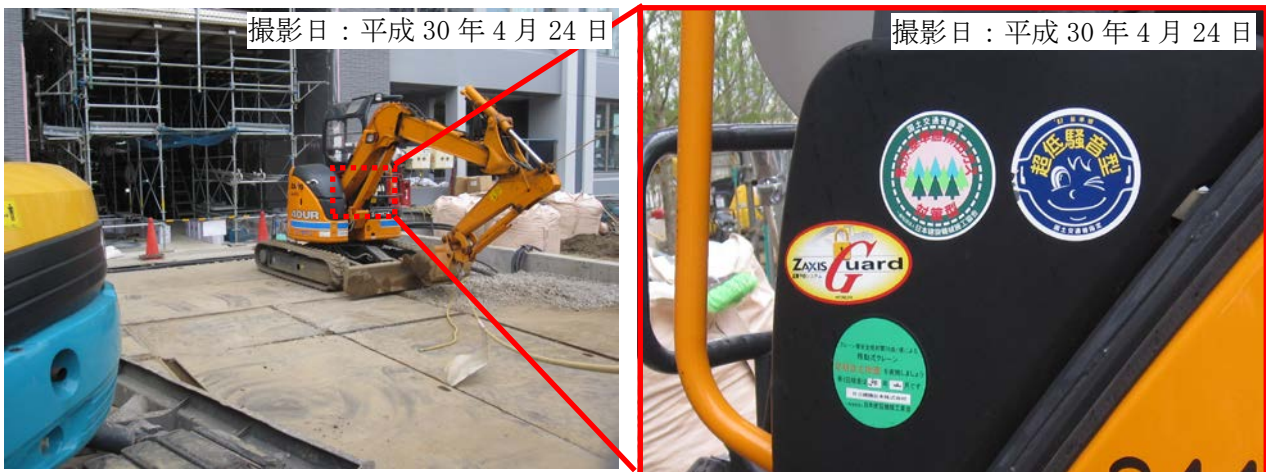
写真 6-1(2) 排出ガス対策型建設機械の使用状況
