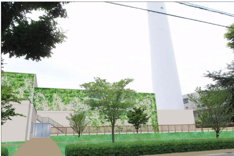
工場棟の高さを抑え、道路前面及び周囲を緑化することで、視認性を和らげている。なお、煙突は既存を再使用する。
