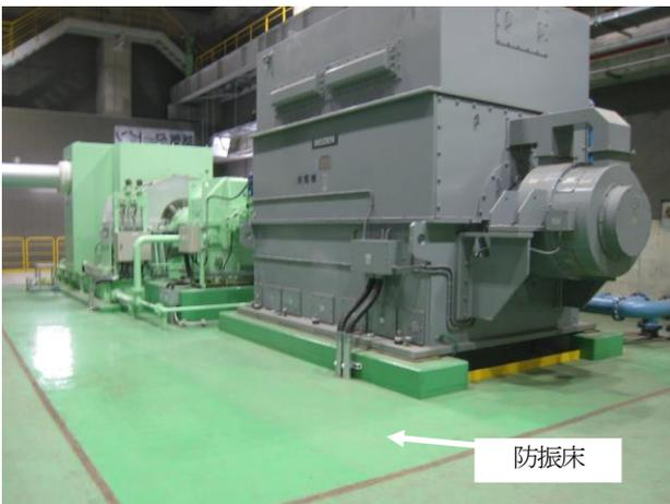
写真 6-15 蒸気タービン発電機の設置状況写真
