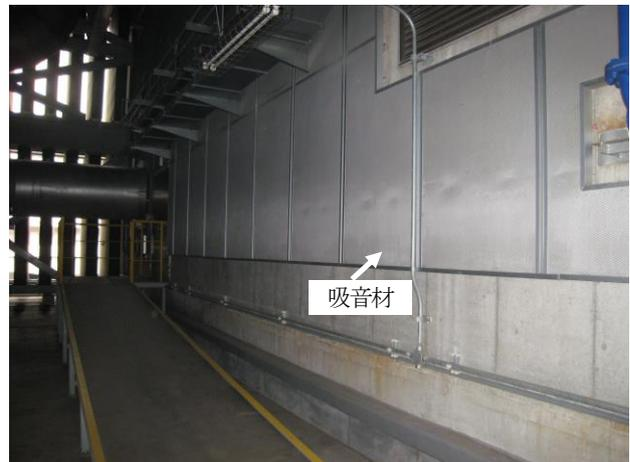
写真 6-10 吸音材の設置状況
