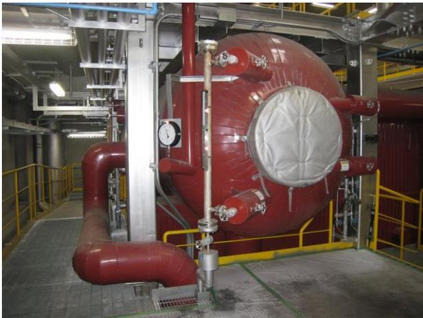
写真 6-21 廃熱ボイラの設置状況 (炉室内)
