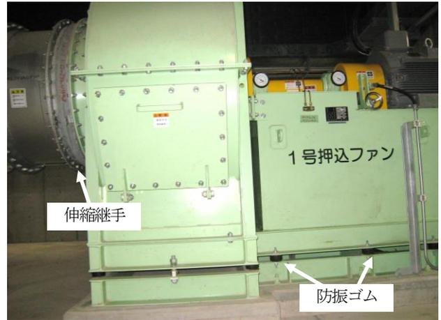
写真 6-14 防振ゴム・伸縮継手の設置状況
