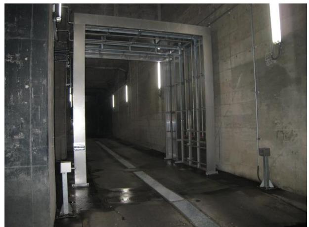
写真 6-6 自動洗車装置の設置状況
