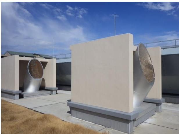
写真 6-11 消音器の設置状況
