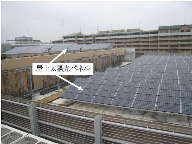
写真 6-19 太陽光パネルの設置状況
