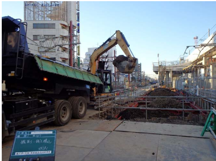
写真2-20 建設発生土の積込み状況（平成31年1月22日）
