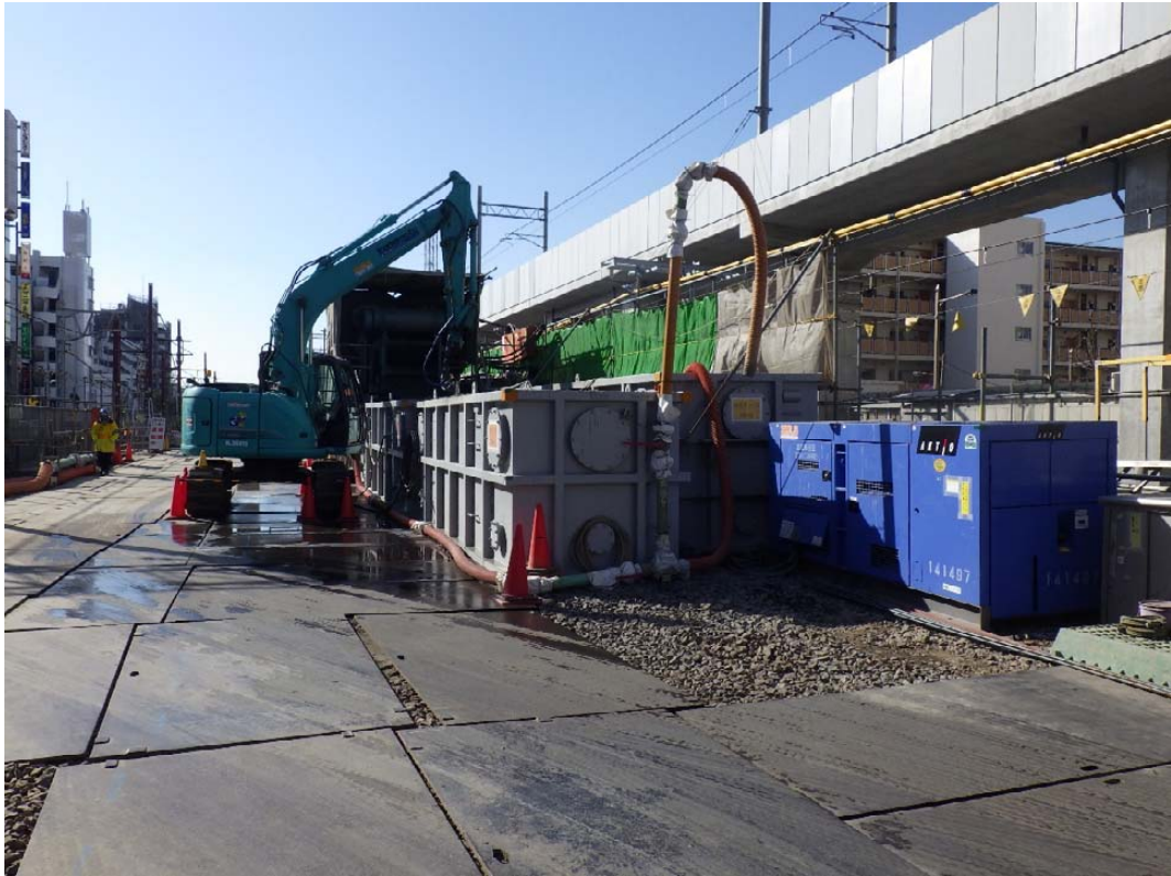
写真2-3 建設泥土の場内水切りの状況（平成30年1月23日）
