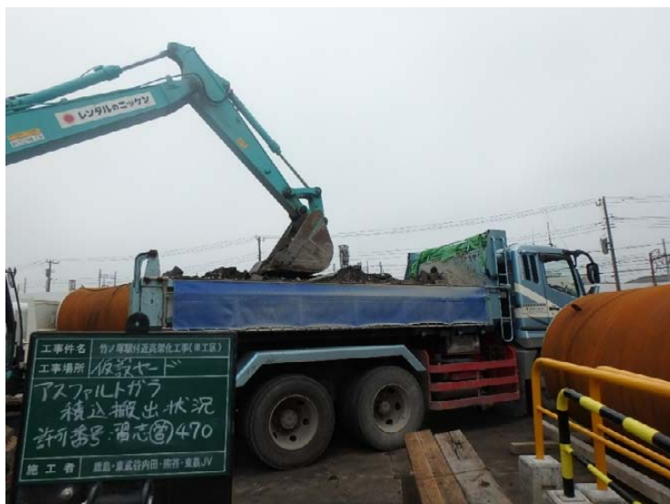
写真2-15 アスファルトがらの積込状況（平成29年10月11日）
