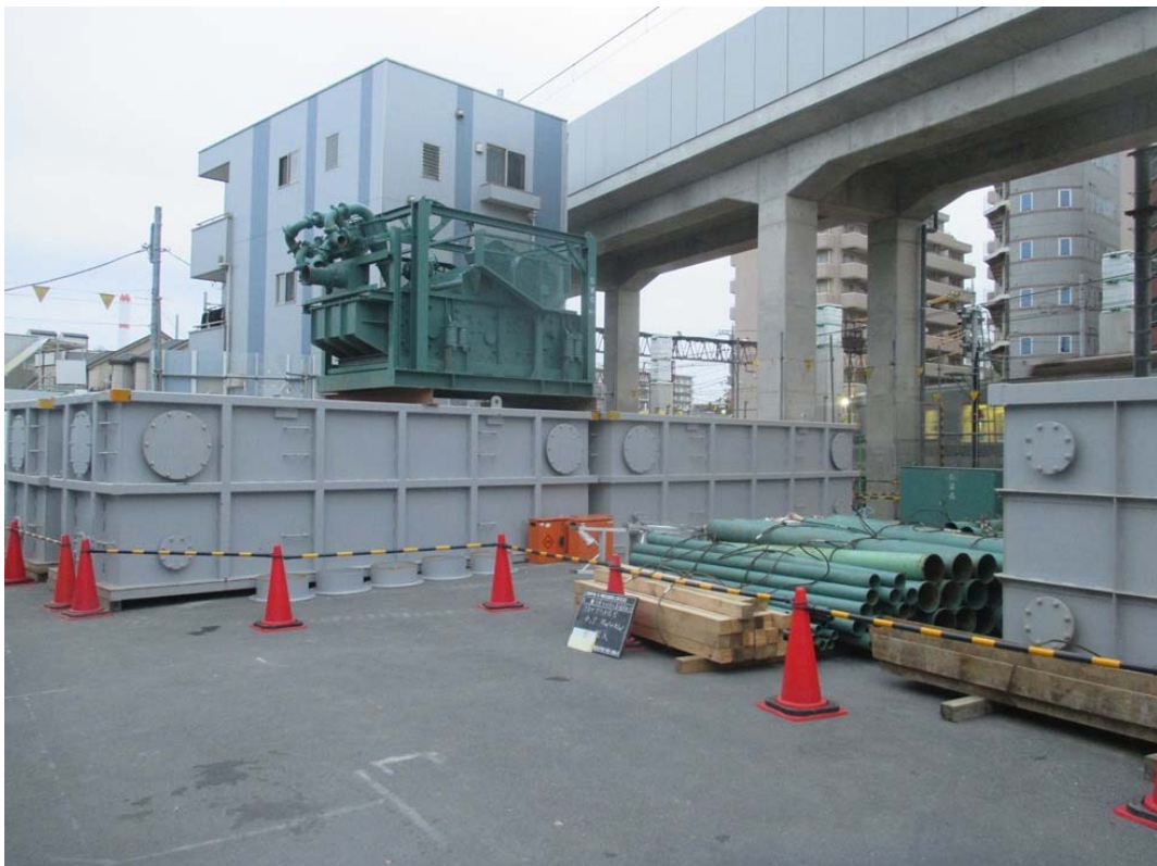
写真2-4 安定液の循環タンクの状況（平成29年10月11日）
