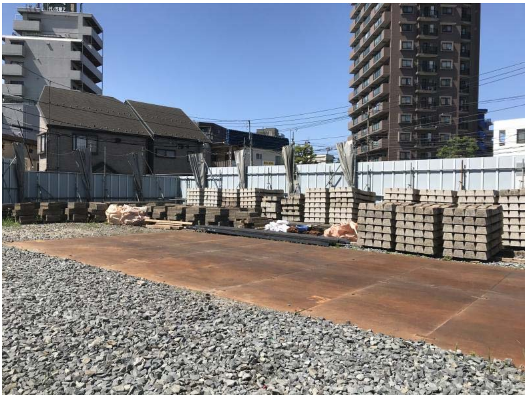
写真2-2 マクラギの保管状況（平成29年4月26日）
