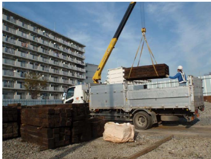
写真2-17 マクラギの積み込み状況（平成30年3月26日）
