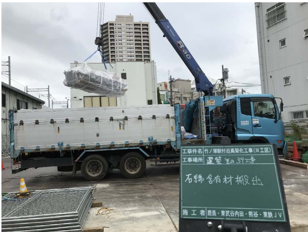
写真2-12 石綿含有材料の搬出状況（平成30年10月8日）
