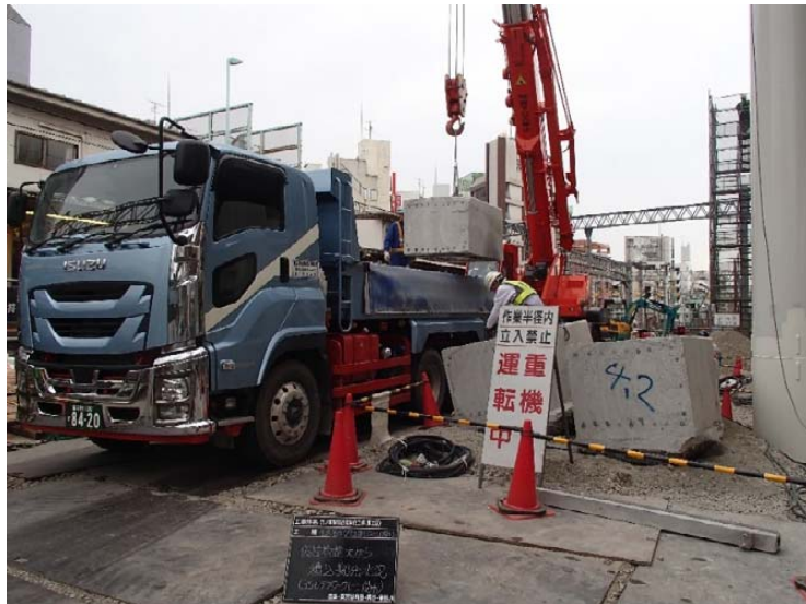
写真2-14 コンクリートがらの積込状況（平成29年4月17日）
