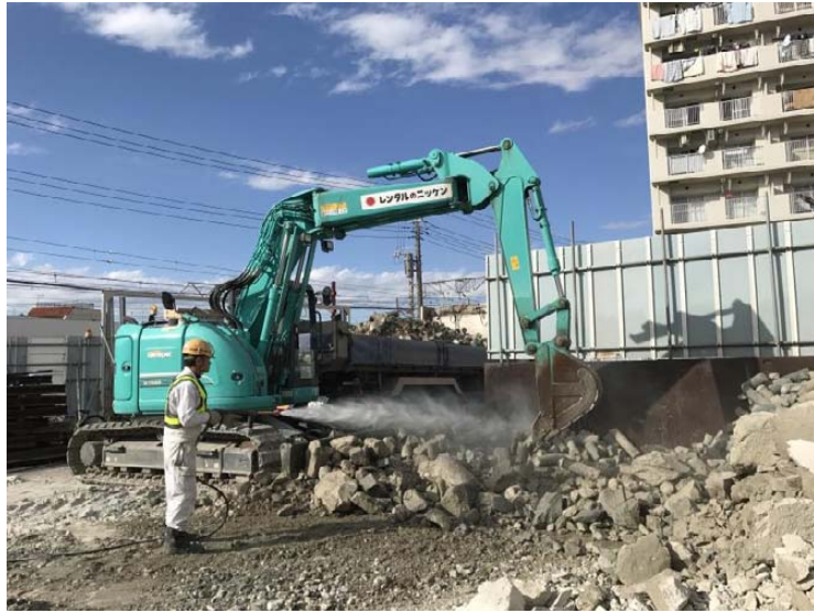
写真2-19 モルタルの積込状況（平成29年11月11日）
