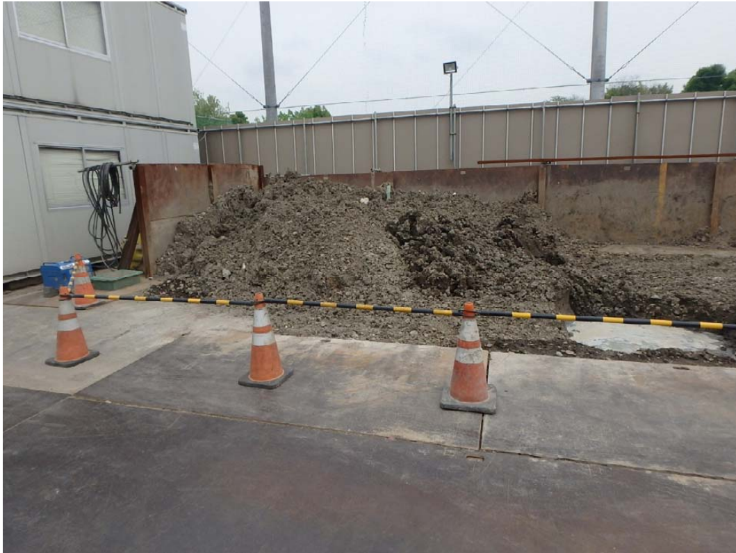
写真2-5 建設発生土の現場仮置き・水切りの状況（平成29年4月21日）
