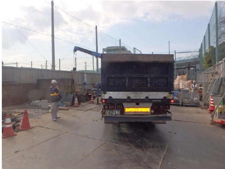
写真2-13 鉄骨・鋼くずの積込状況（平成30年3月25日）
