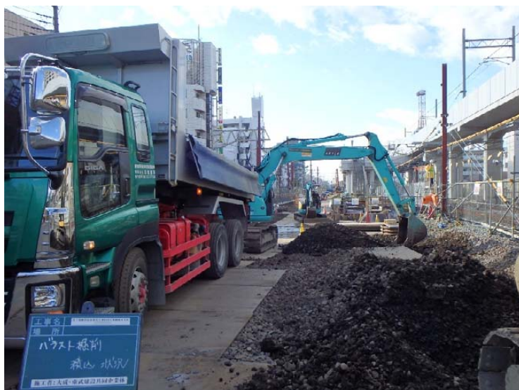
写真2-18 バラストの積み込み状況（平成31年2月4日）
