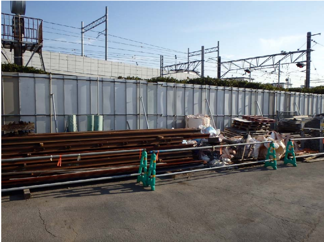
写真2-1 レールの保管状況（平成30年12月20日）
