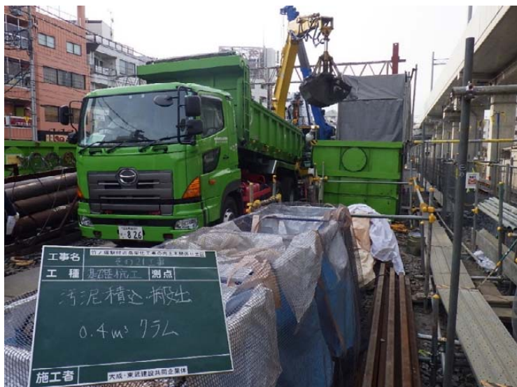
写真2-21 建設泥土の積込状況（平成30年2月1日）
