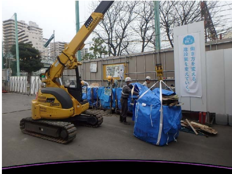
写真2-16 混合廃棄物の積込状況（平成31年3月26日）
