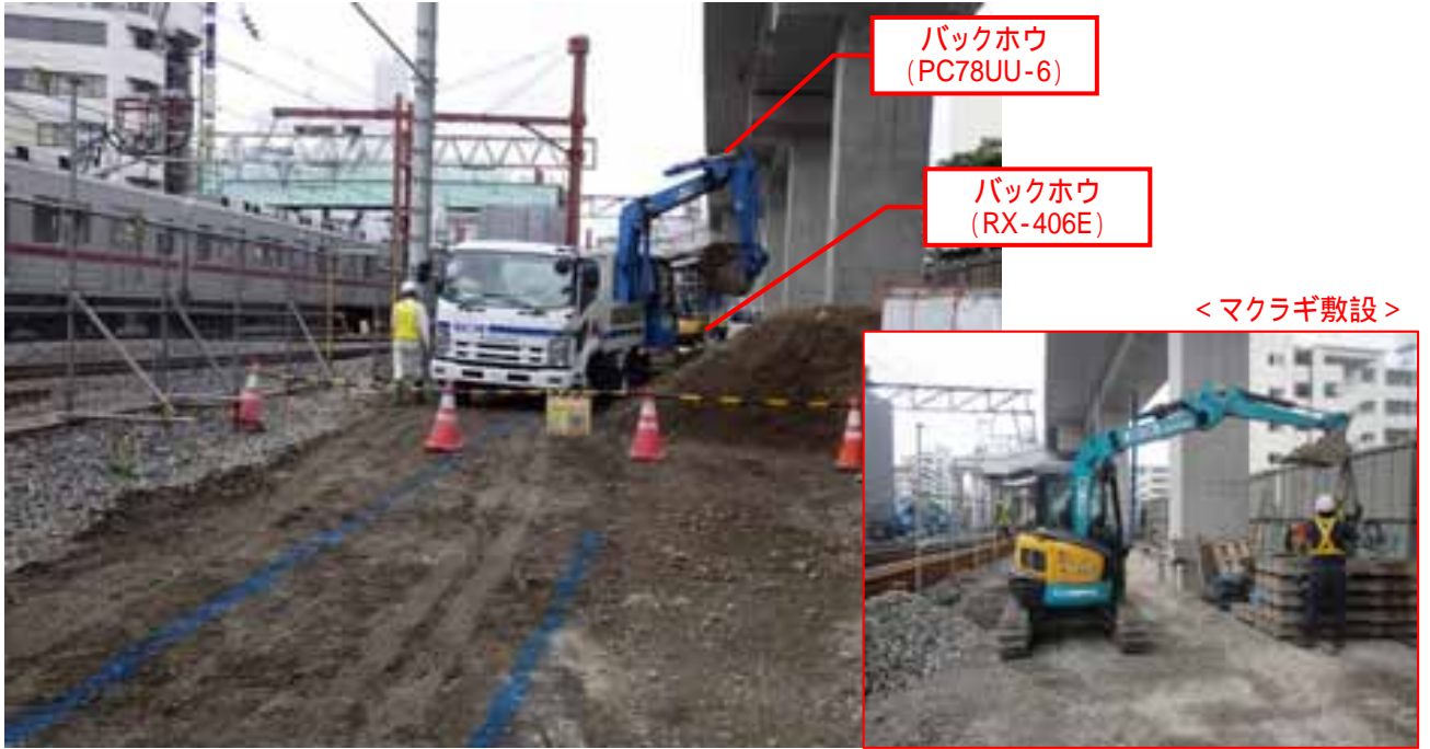
写真 1-9 西 No.6 (路盤工) の施工状況 (平成 29 年 5 月 15 日)
