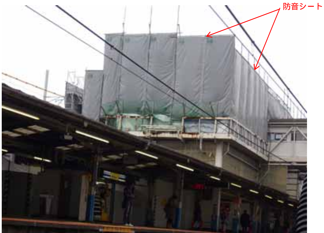
写真1-38 防音シートの設置状況 (平成29年11月14日)
