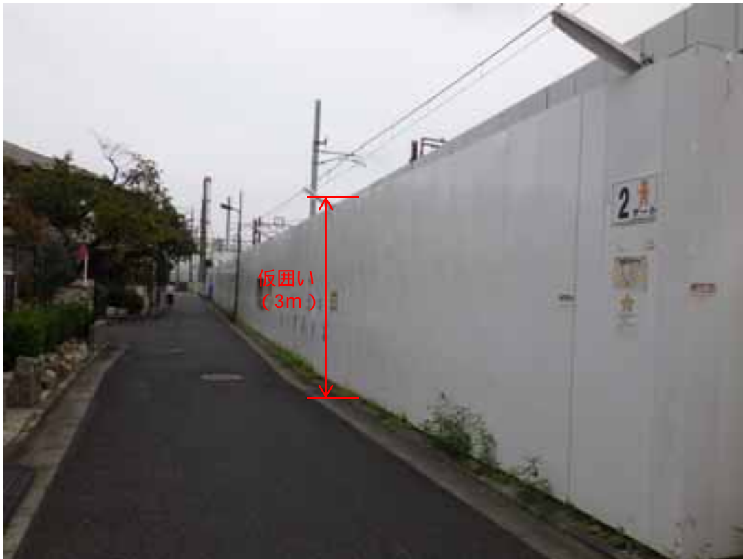
写真 1-50 仮囲いの設置状況（平成 30 年 10 月 16 日）
