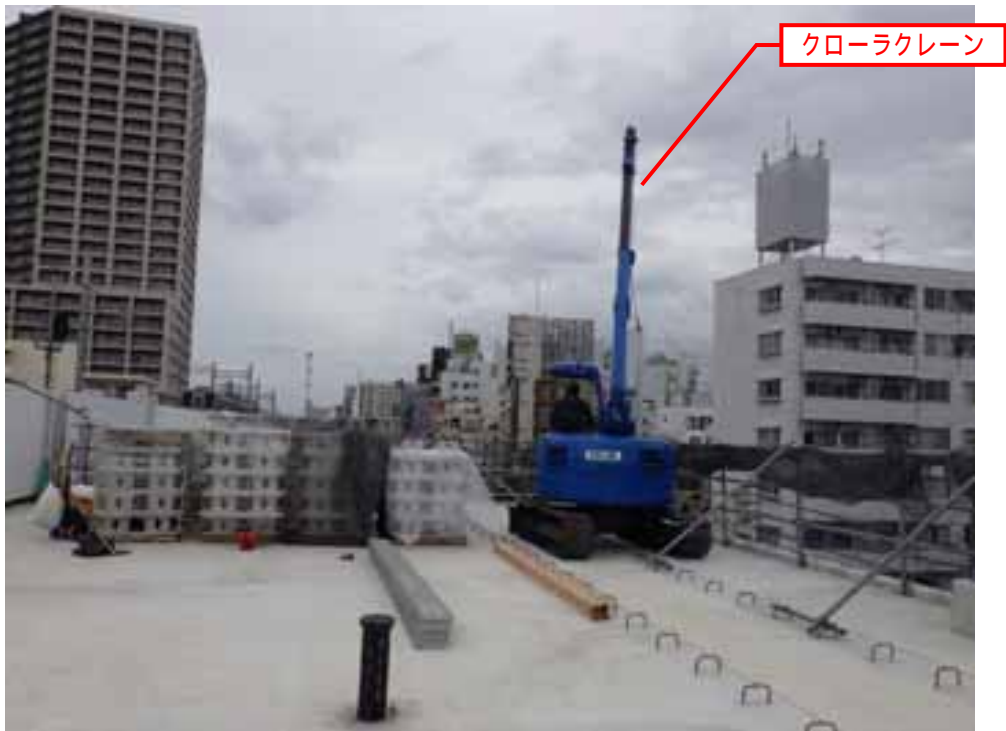
写真 1-5 西 No.4 (高欄工) の施工状況 (平成 29 年 10 月 6 日)
