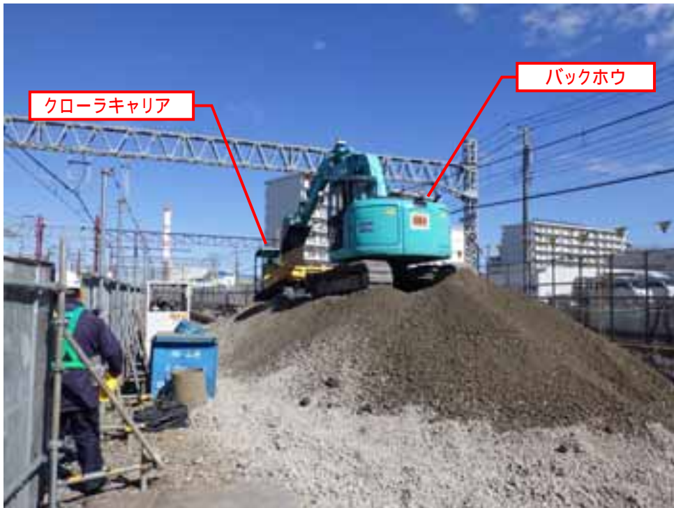
写真 1-21 東 No.11 (路盤工) の施工状況 (平成 31 年 2 月 12 日)
