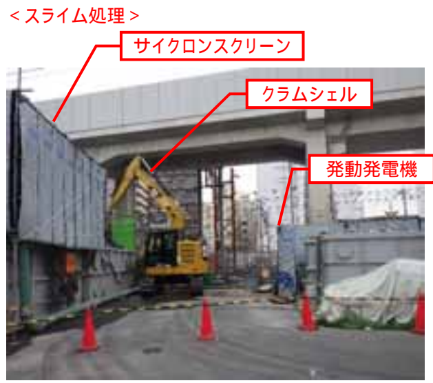
写真 1-17 西 No.10 (基礎杭工) の施工状況 (平成 29 年 11 月 8 日)
