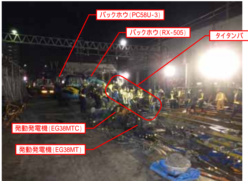
写真 1-25 西 No.14 (軌道工 (仮上り緩行線切替)) の施工状況 (平成 30 年 9 月 23 日)
