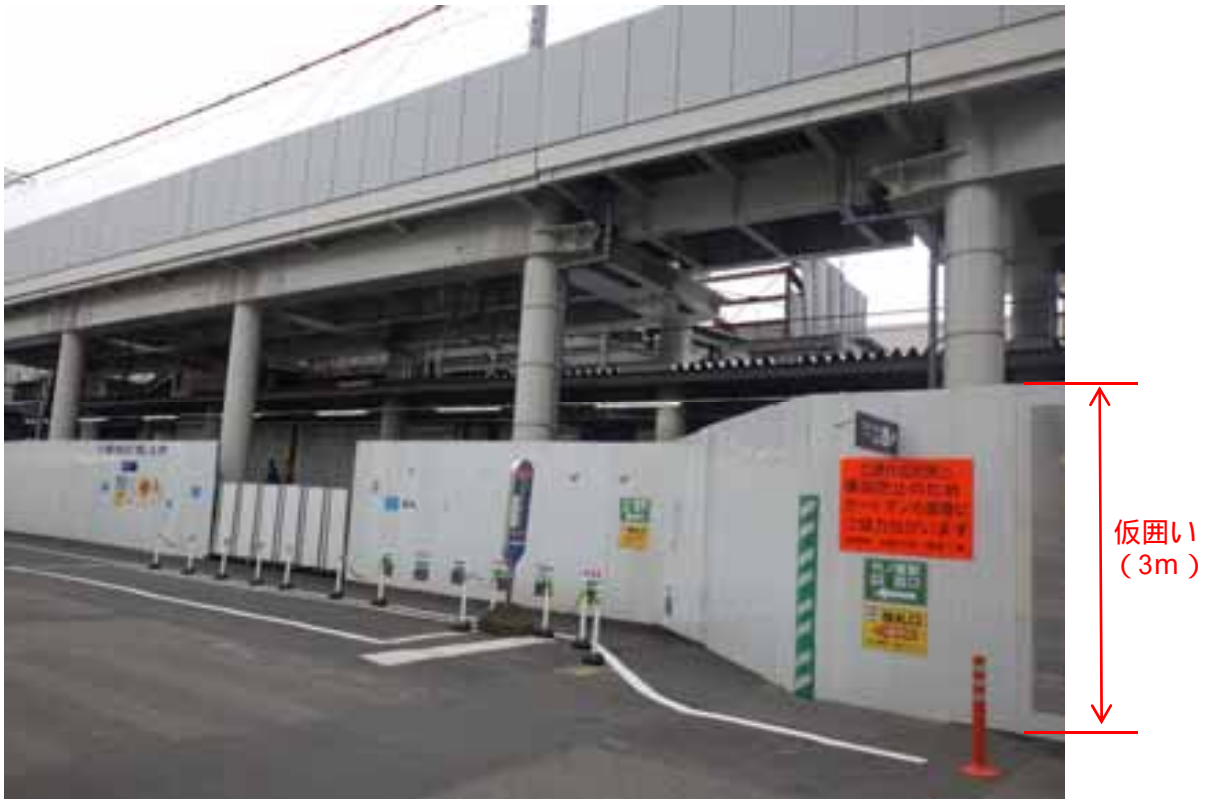
写真1-36 仮囲い(3m)の設置状況(平成29年11月8日)
