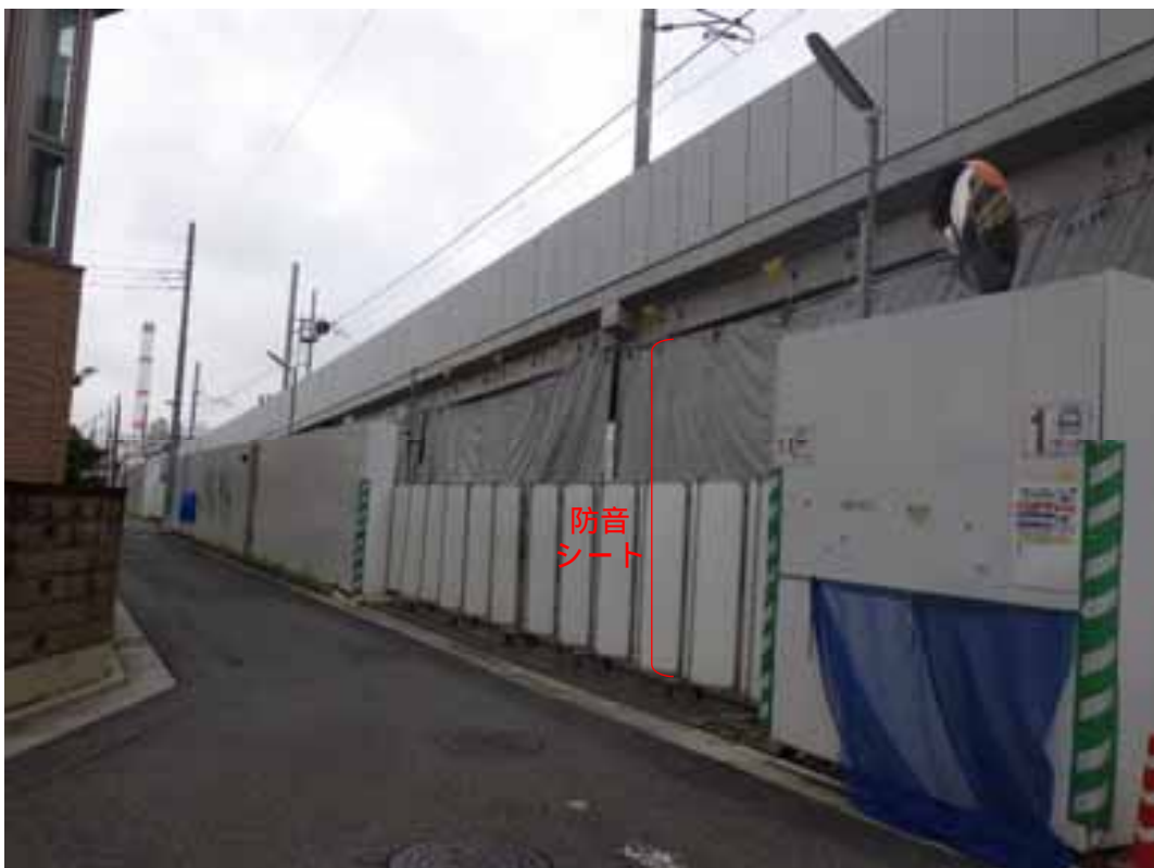
写真 1-37 防音シートの設置状況(平成 29 年 9 月 6 日)
