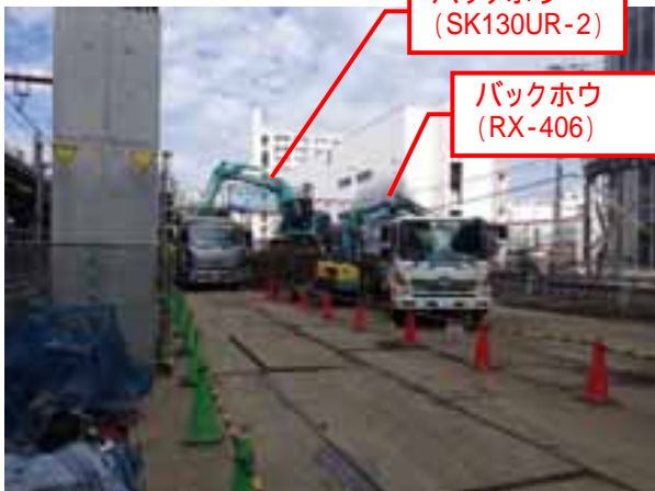
写真 1-13 東 No.8 (既設構造物撤去工) の施工状況 (平成 30 年 10 月 24 日)
