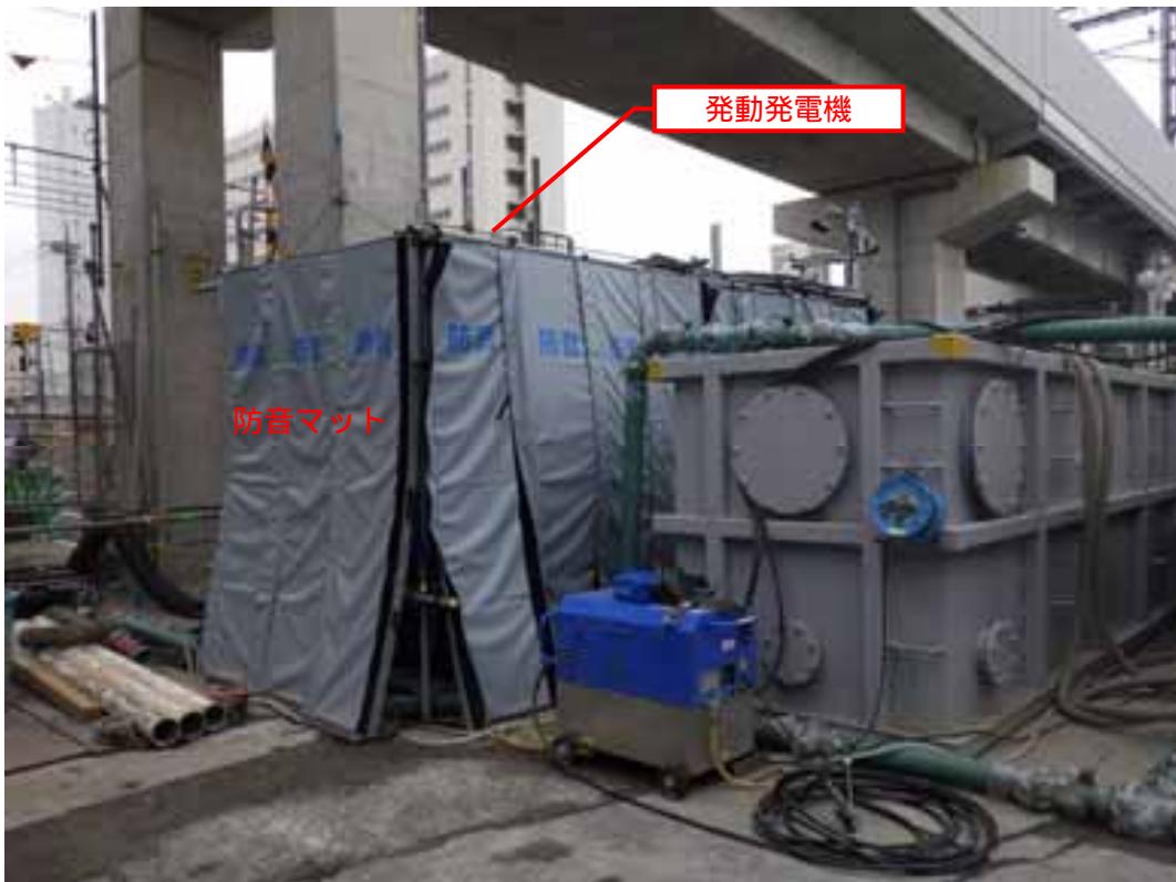
写真1-41 防音マットの設置状況 (平成29年11月8日)
