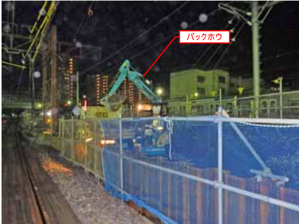
写真 1-2 東 No.2 (掘削工) の施工状況 (平成 29 年 7 月 29 日)
