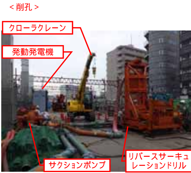
写真 1-17 西 No.10 (基礎杭工) の施工状況 (平成 29 年 11 月 8 日)
