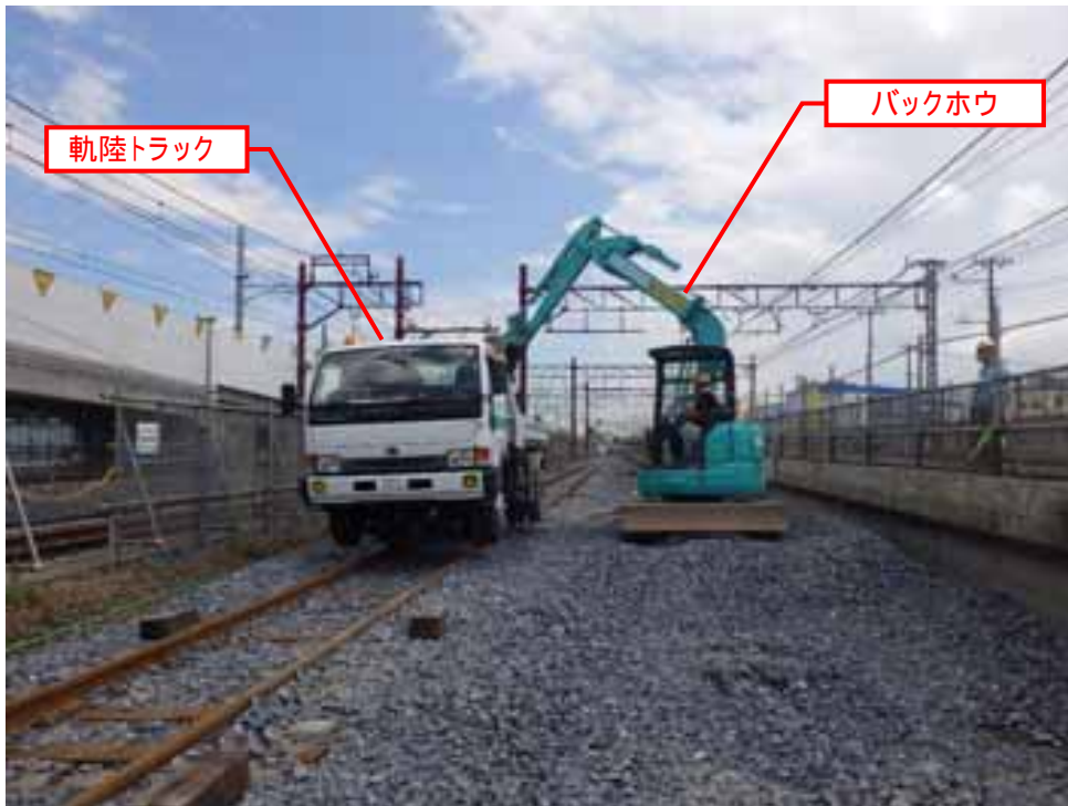
写真 1-26 西 No.15 (軌道工) の施工状況 (平成 30 年 7 月 9 日)
