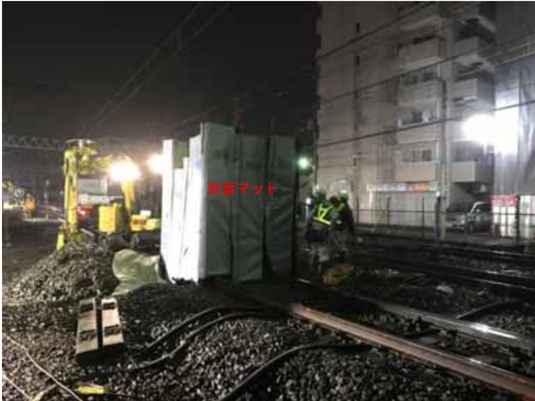
写真1-44 防音マットの設置状況(平成30年2月23日)
