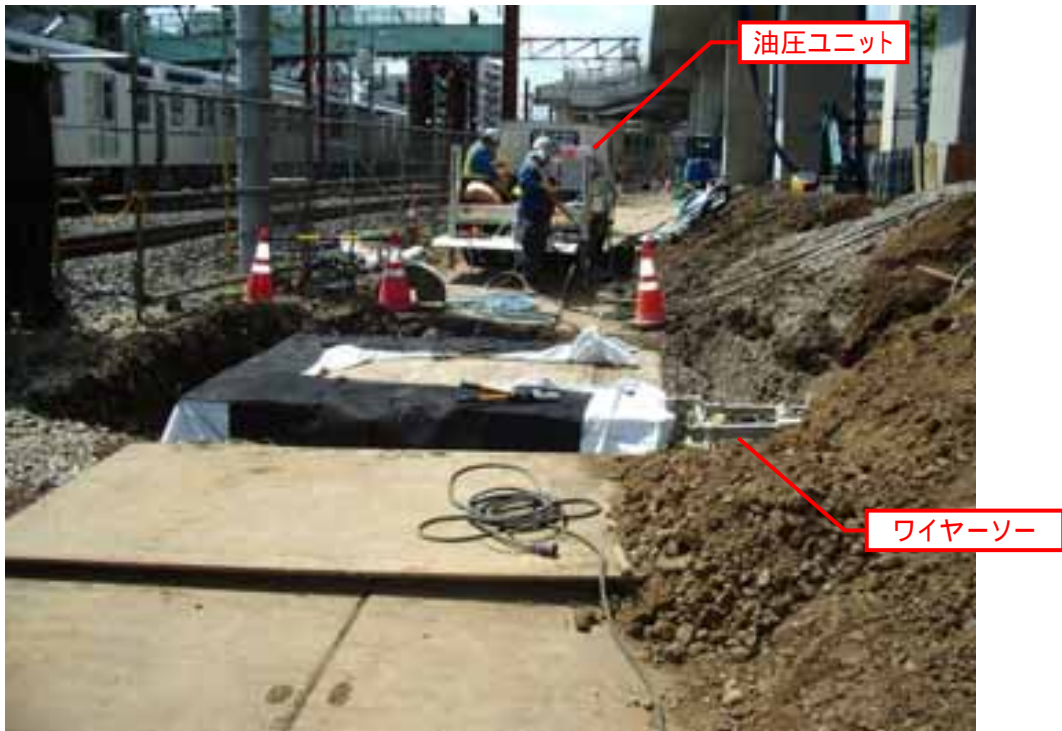
写真 1-8 西 No.6 (既設構造物撤去工) の施工状況 (平成 29 年 4 月 25 日)
