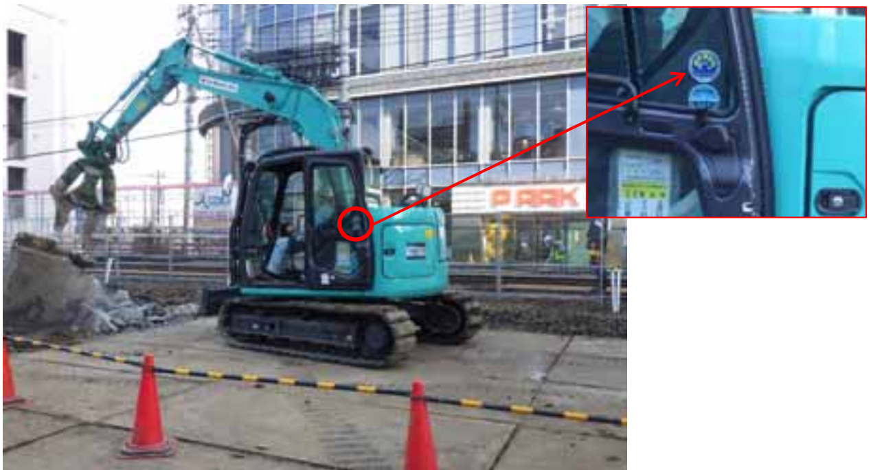
写真1-31 超低騒音型の機械の使用（コンクリート破砕機）（平成30年10月24日）
