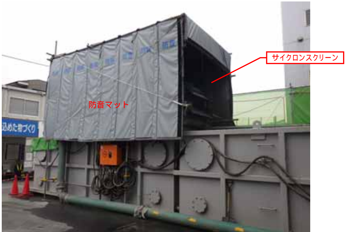
写真1-42 防音マットの設置状況（平成29年11月8日）
