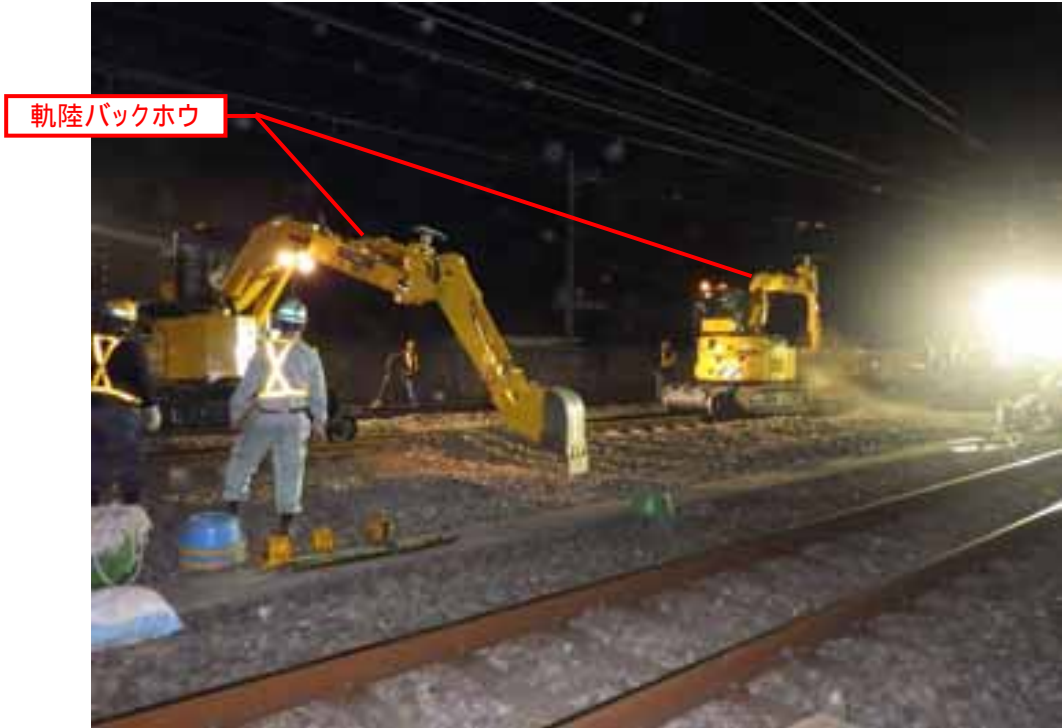
写真 1-27 西 No.16 (軌道工 (仮下り緩行線切替)) の施工状況 (平成 29 年 8 月 27 日)
