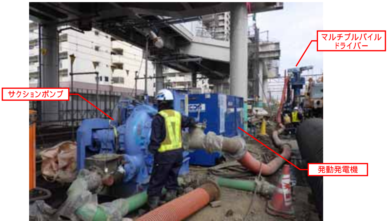
写真 1-6 西 No.5 (基礎杭工) の施工状況 (平成 30 年 2 月 21 日)
