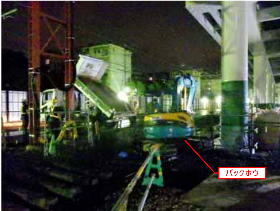
写真 1-4 西 No.3 (軌道工) の施工状況 (平成 29 年 7 月 5 日)
