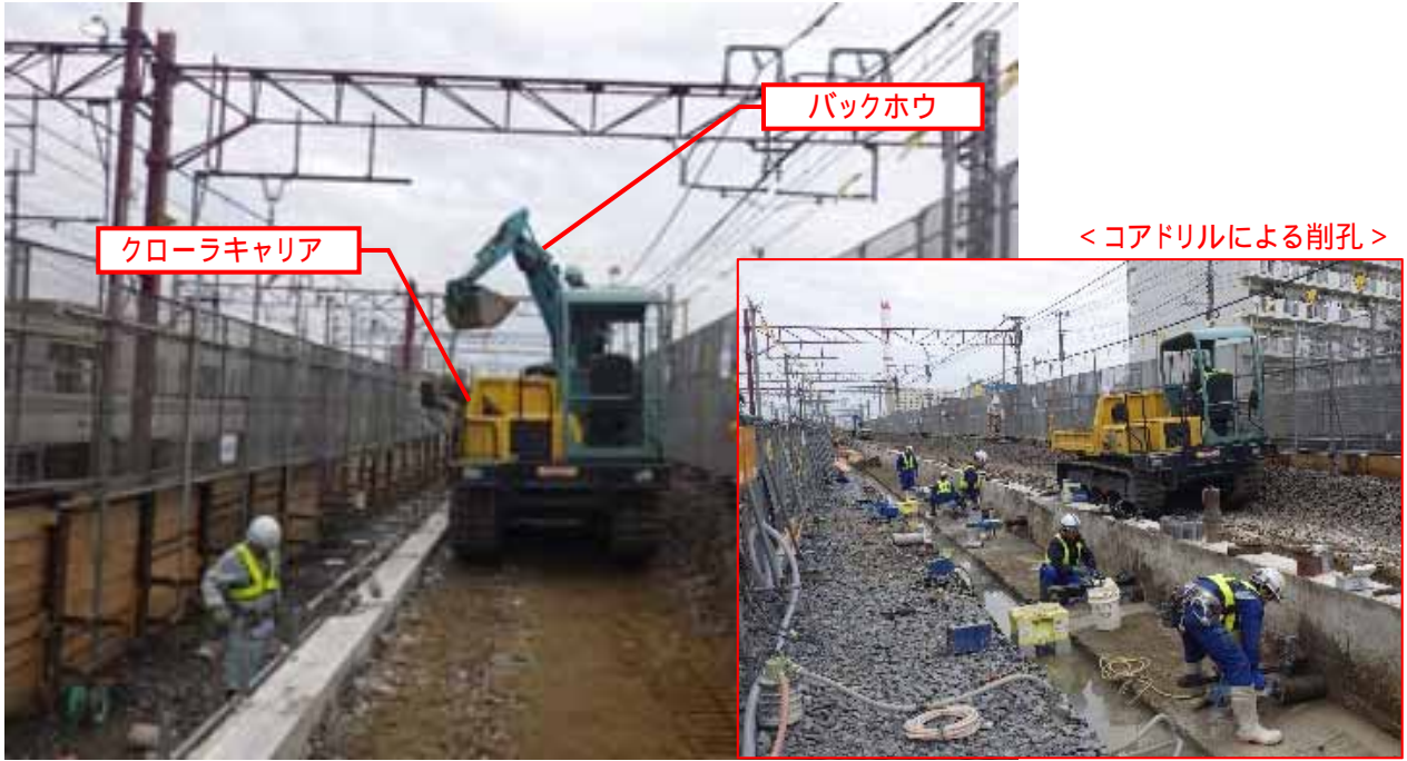
写真 1-22 東 No.12 (既設構造物撤去工) の施工状況 (平成 30 年 11 月 13 日)
