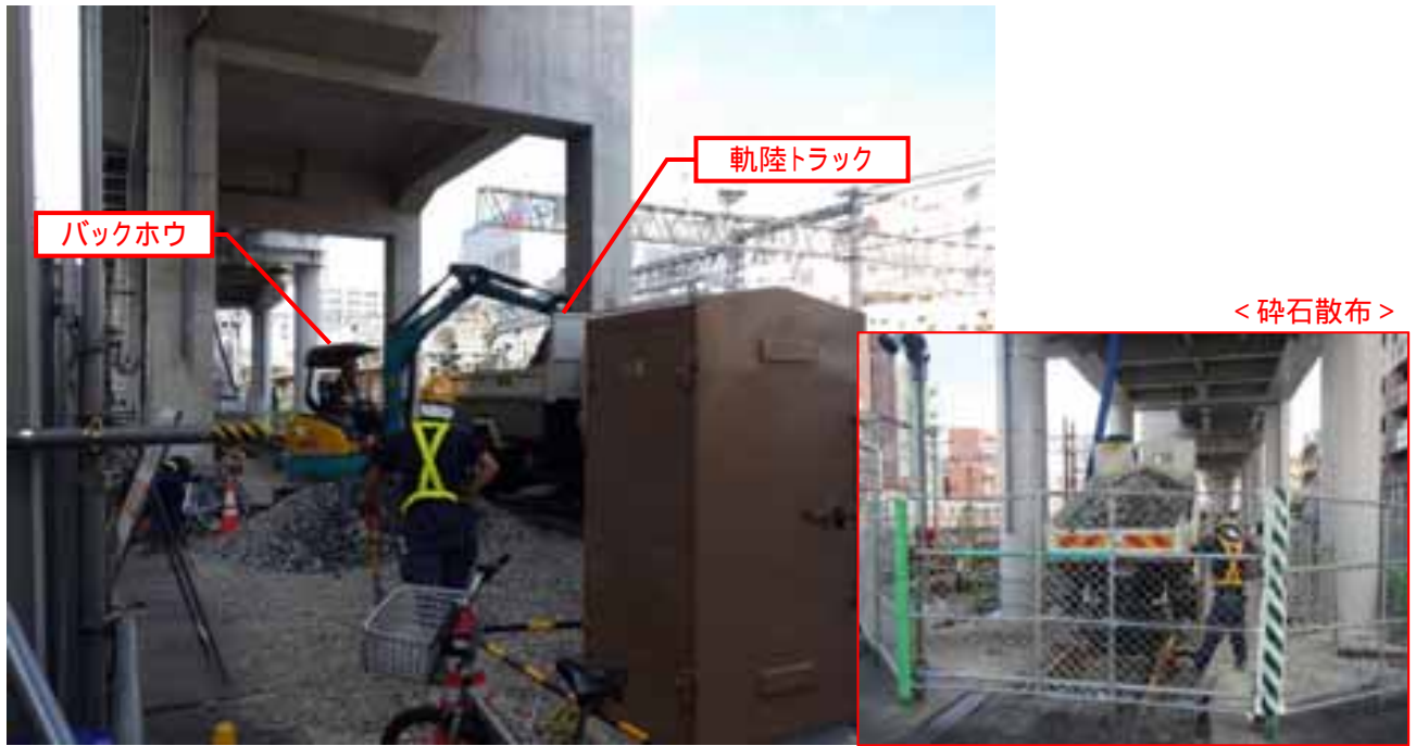
写真 1-11 西 No.7 (軌道工) の施工状況 (平成 29 年 7 月 12 日)
