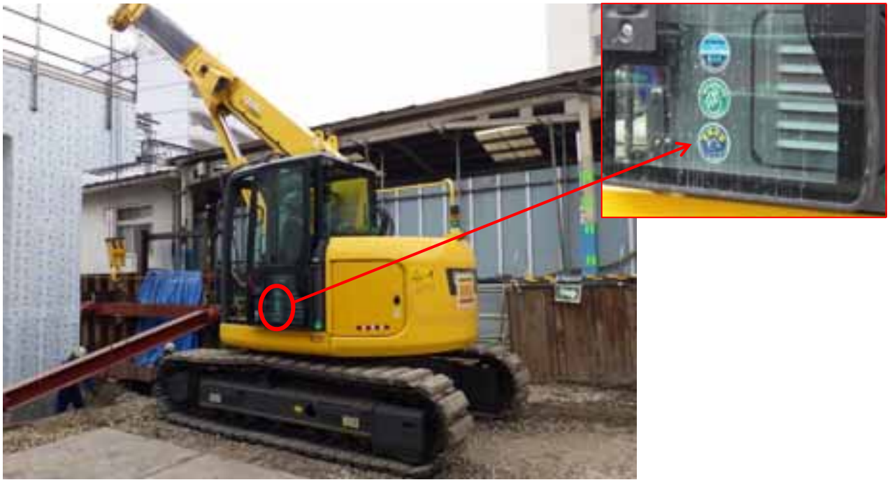
写真1-30 低騒音型の機械の使用（クローラクレーン）（平成30年4月24日）
