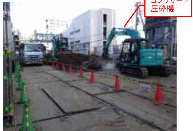
写真 1-13 東 No.8 (既設構造物撤去工) の施工状況 (平成 30 年 10 月 24 日)
