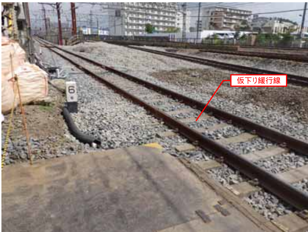
写真 1-51 ロングレールの設置状況（仮下り緩行線）（平成 29 年 8 月 30 日）
