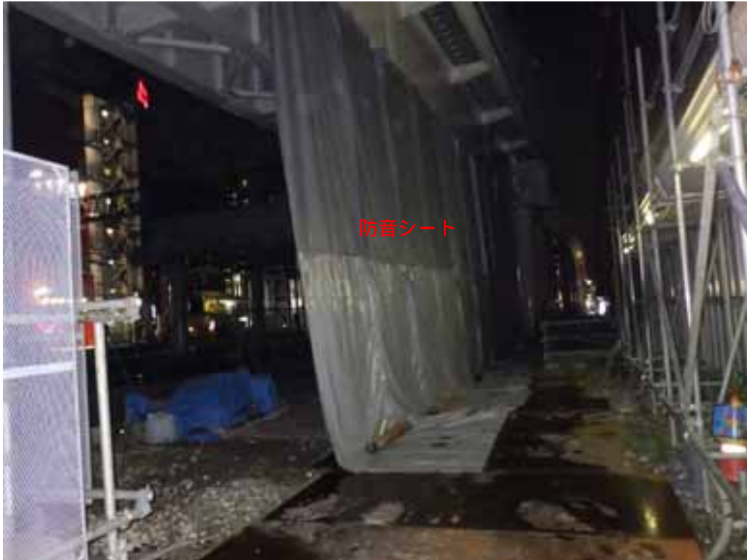
写真1-40 防音シートの設置状況 (平成30年9月23日)
