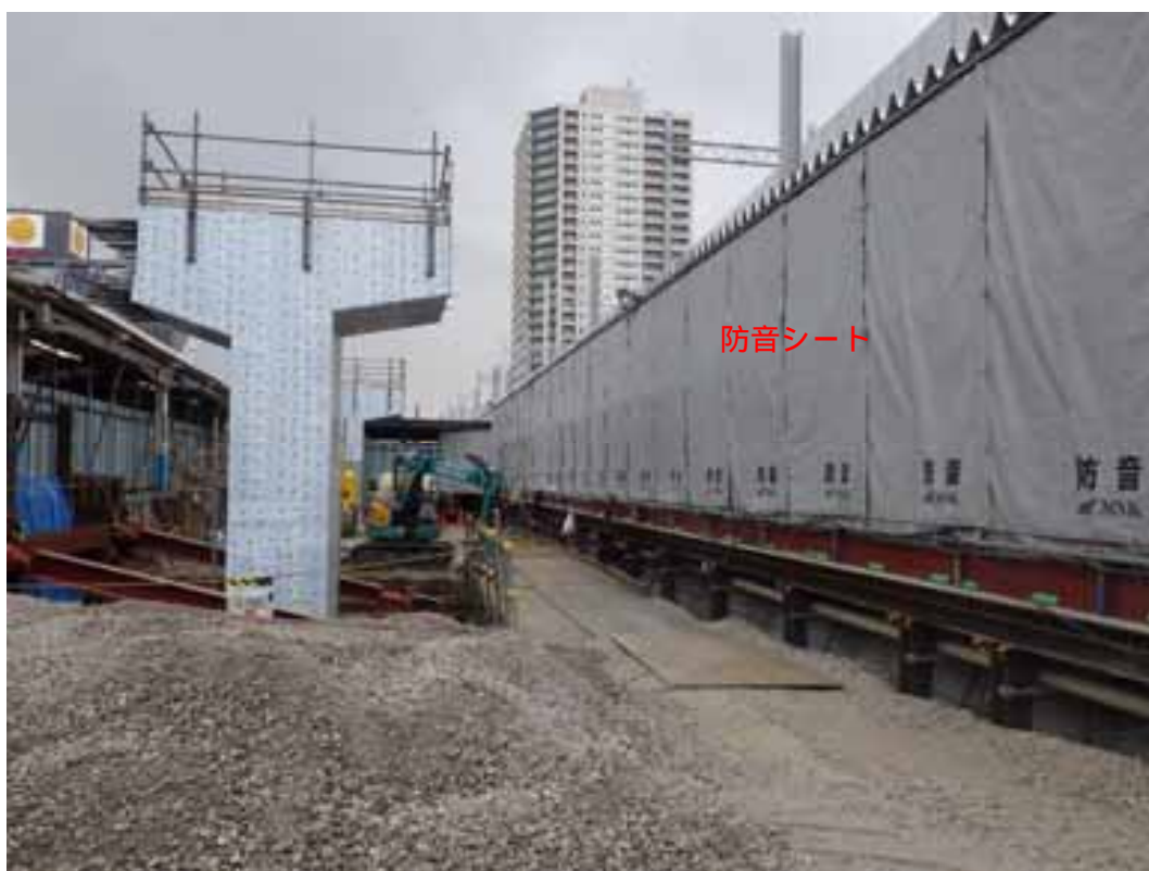
写真1-39 防音シートの設置状況 (平成30年4月24日)
