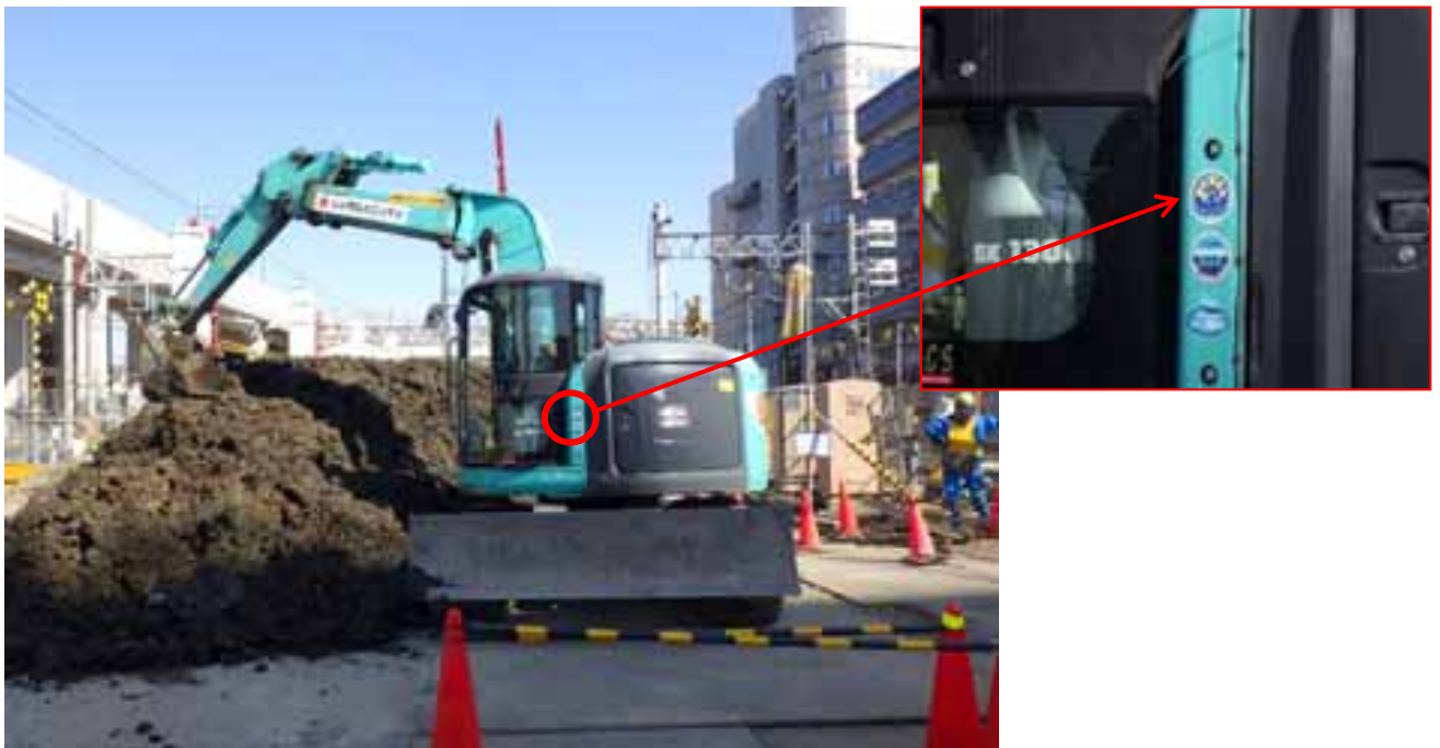
写真1-29 超低騒音型の機械の使用（バックホウ）（平成30年2月20日）
