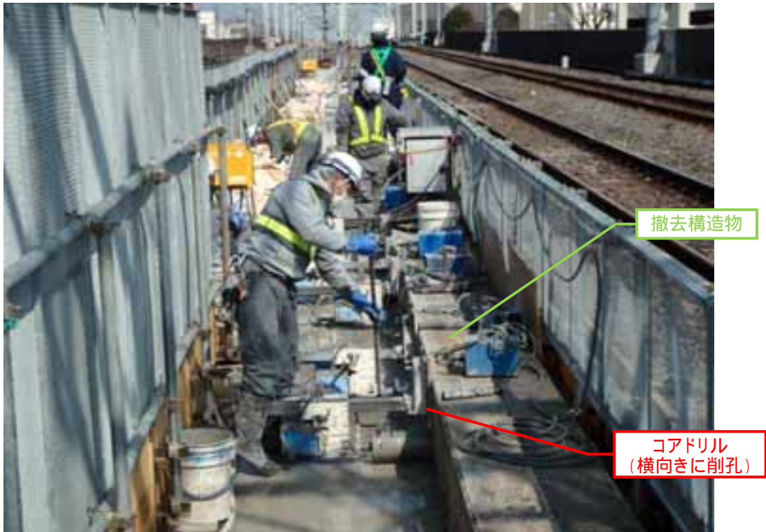
写真1-34 低振動の工法（コアドリル 1 ）の作業状況（平成30年2月27日）
