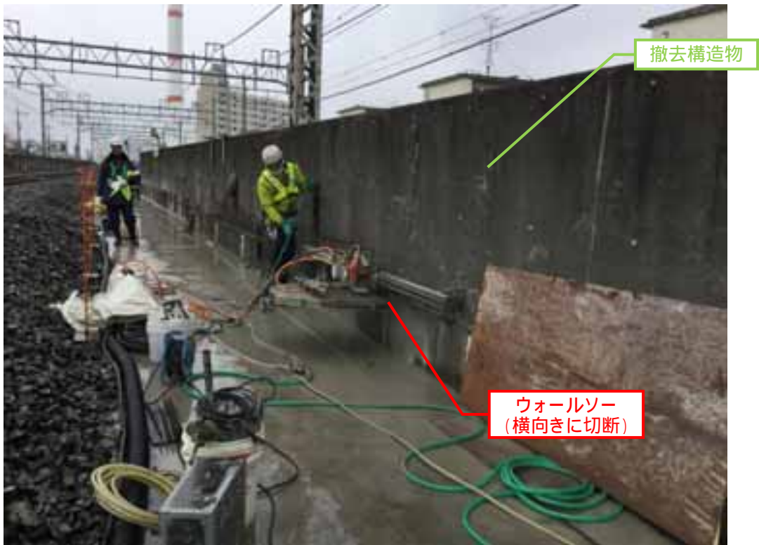
写真1-35 低振動の工法（ウォールソー 2 ）の作業状況（平成30年2月22日）
