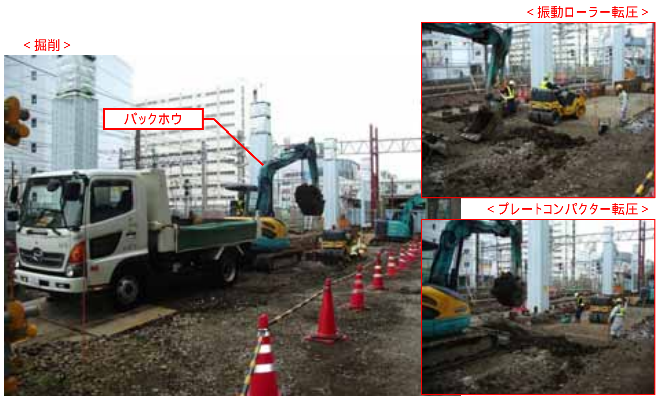
写真 1-23 西 No.13 (路盤工) の施工状況 (平成 29 年 4 月 7 日)
