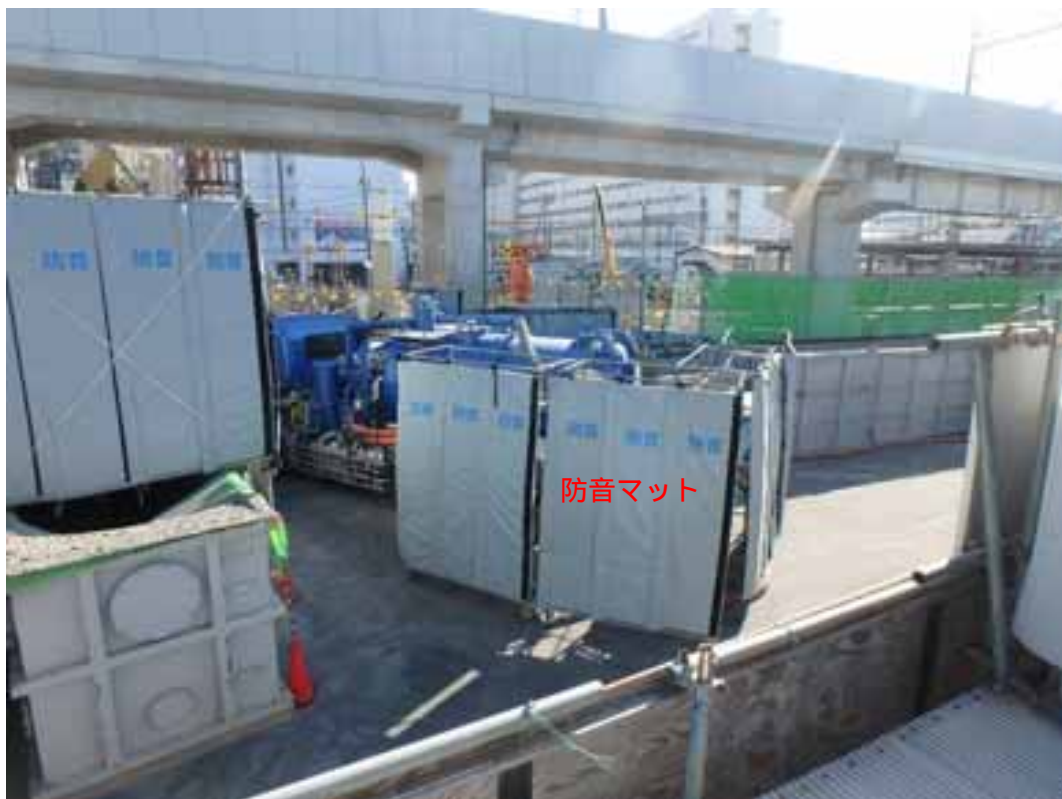
写真1-43 防音マットの設置状況（平成29年11月8日）
