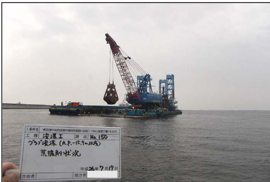
写真4-1 浚渫土の活用の状況（掘削状況）
