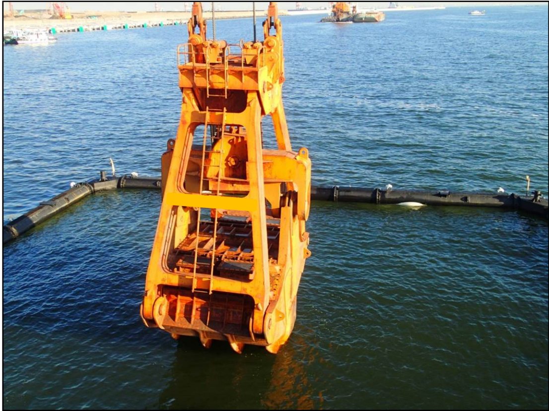
写真3-6 密閉蓋式グラブの使用状況
