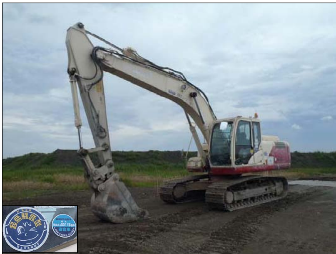
写真3-4(1) 排出ガス対策型・超低騒音型建設機械の使用状況（バックホウ）
