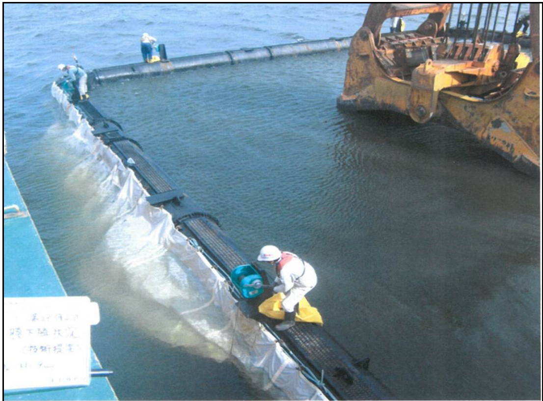
写真3-7 汚濁防止膜の設置状況
