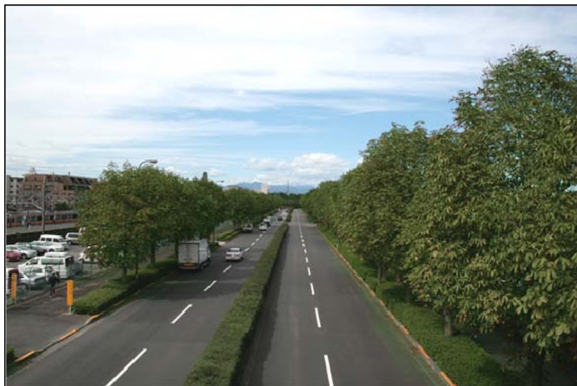
[工事の完了後予測]
