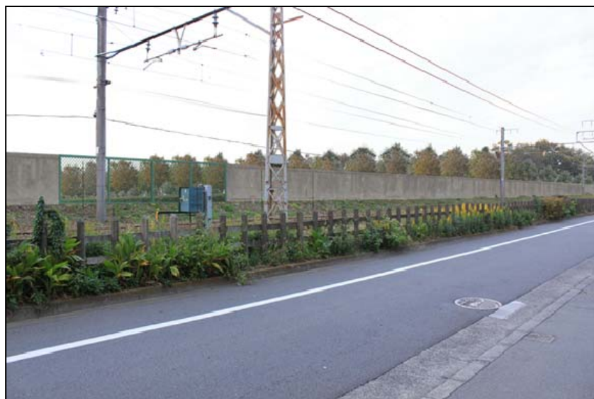
[工事の完了後予測]
