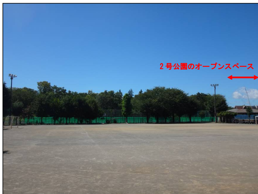
[工事の完了後]
